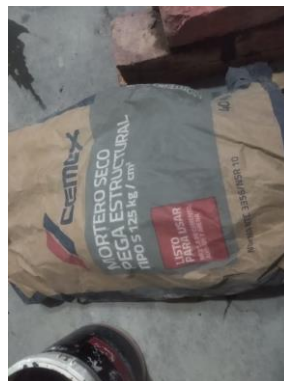
Figura 11. Mortero seco para pega de mampostería estructural. Elaboración propia
