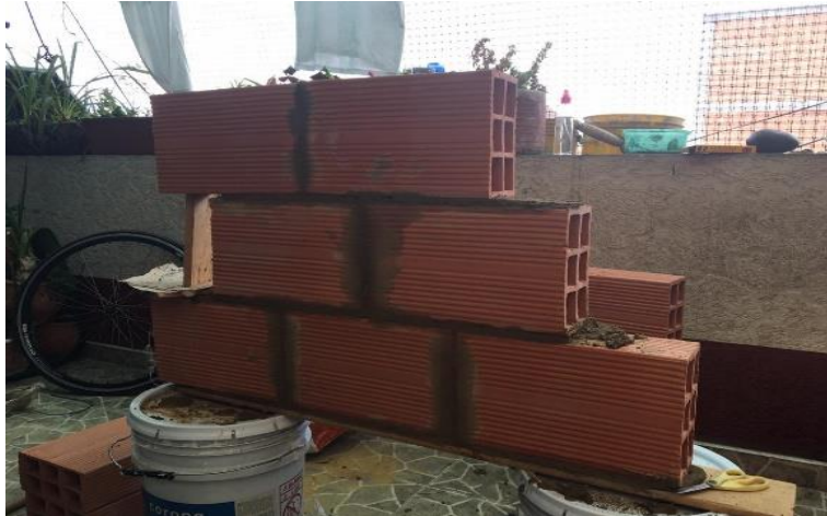
Figura 15. Levantamiento de muro con pega de mampostería estructural. Elaboración propia
