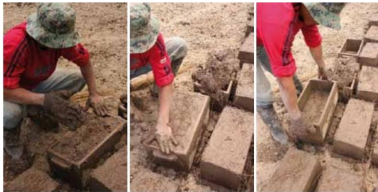
Figura 1. Proceso de elaboración de un adobe. Se observa el moldeado de la elaboración de adobes. Tomado de: arquitectura tradicional en Azuay y Cañar (2011) Recuperado de: https://issuu.com/inpc/docs/arquitectura
