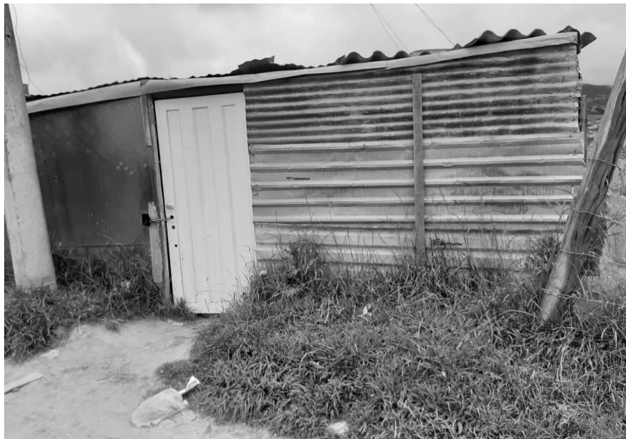
Figura 16. foto de vivienda en Usme se realizó un recorrido por el sector y estas son algunas de las casas que se encontraron en mal estado. Elaboración propia.
