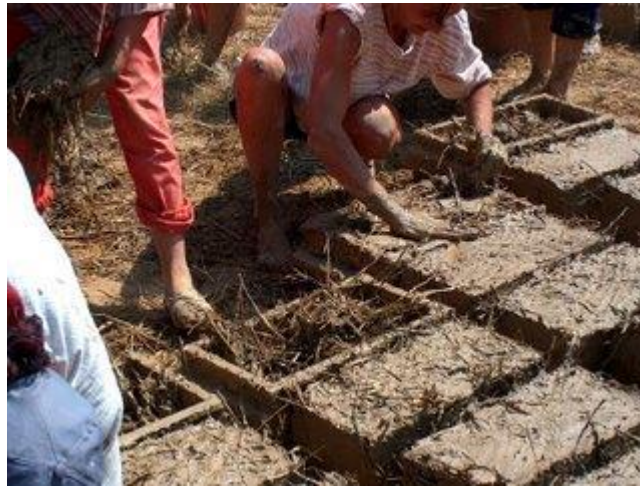
Figura 5. Proceso de fabricación de adobes. en las figuras, se ve el orden de los adobes secándose al aire libre manera y como presiona el barro para que quede uniforme. Tomado de: Sergio Ramírez (24, marzo, 2006). Fabricación de adobes. Construcción de adobe. Recuperado de: http://ceramicagrupoj.blogspot.com/2006/03/32-fabricacin-de-adobes-construccin.html
