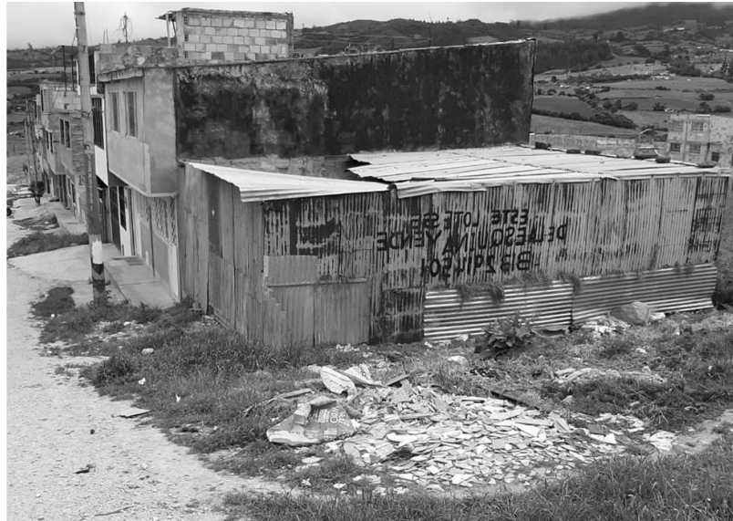
Figura 18 Viviendas deterioradas como se ve en la figura muchas de estas casas son de materiales reciclados. Elaboración propia
