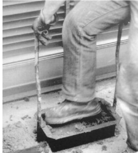
Figura 15. Elaboración del adobe Se observa la compactación de la arcilla en el molde.
