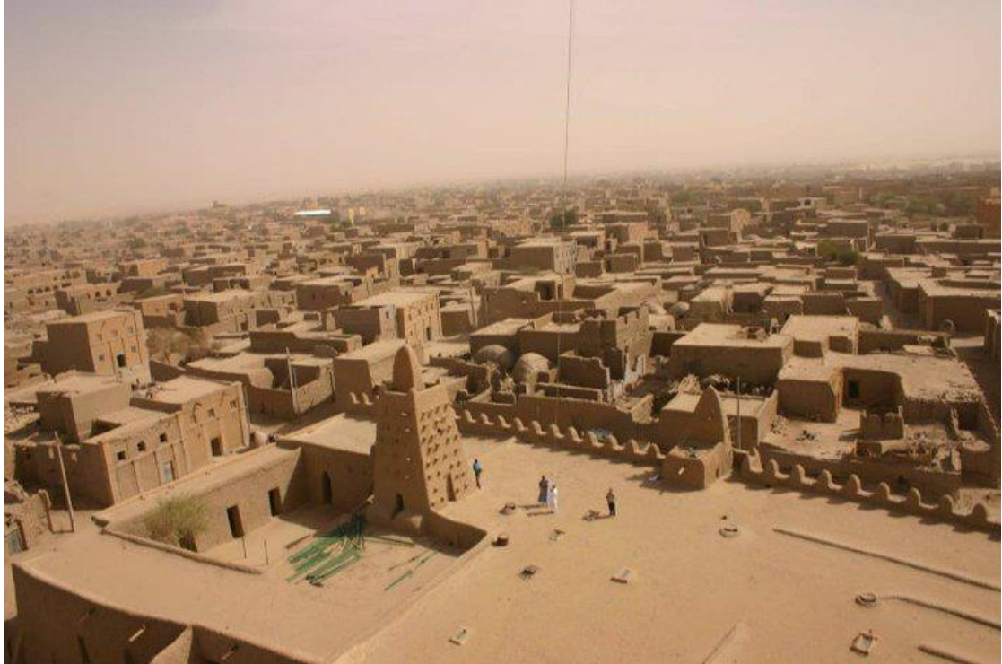
Figura 2. Vista aérea de Tombuctú. Ciudad en construcción en tierra.
