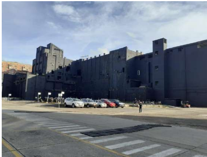
Fig. 5. Fotografía propia. Tomada 6 de septiembre de 2019 – Vista desde el interior de la manzana. Edificio 4. Huella de edificios demolidos.
