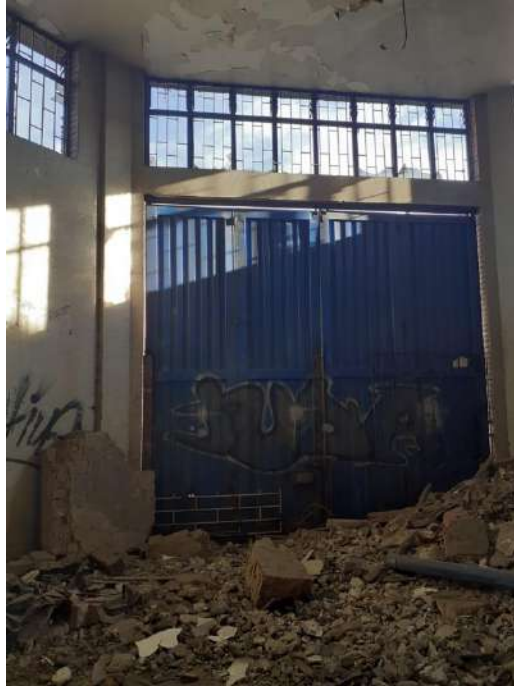
Fig. 4. Fotografía propia. Tomada 6 de septiembre de 2019 – Interior del edificio 4, daños y escombros.
