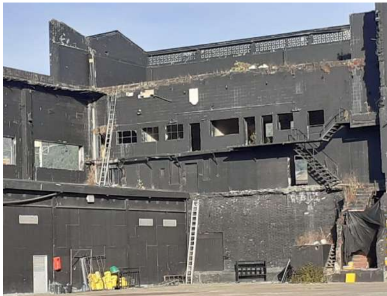
Fig. 7. Fotografía propia. Tomada 6 de septiembre de 2019 – Vista desde el interior de la manzana. Edificio 5. Huella de edificios demolidos.
