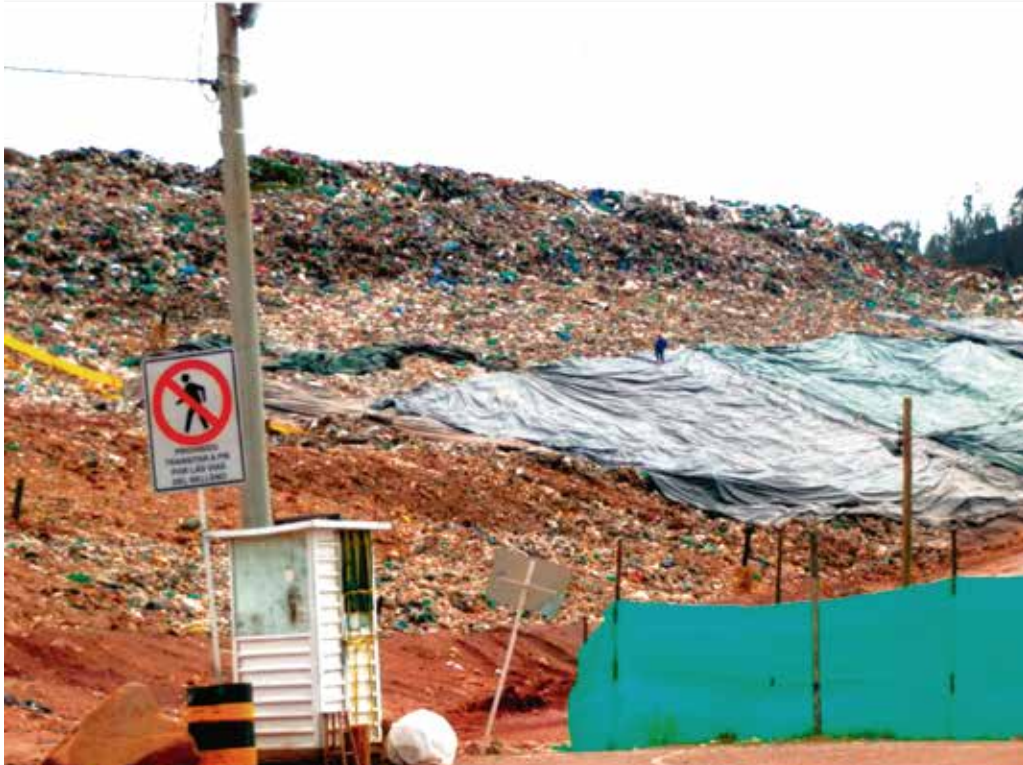
[Fotografía de Romero, J]. (2020). Visual de vaso en operación e instalación de plásticos y geotextiles, desde campamento de obra de terraza VIII. RSDJ, Bogotá, Colombia.
