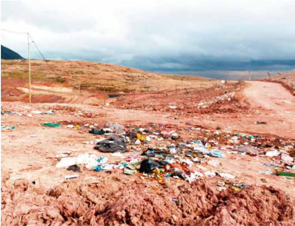
[Fotografía de Romero, J]. (2020). Construcción de caminos para vehículos de carga y utilitarios de obra. RSDJ, Bogotá, Colombia.
