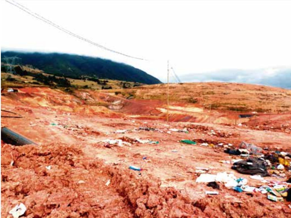
[Fotografía de Romero, J]. (2020). Visual de terraza de optimización, zona VII, para residuos sólidos. RSDJ, Bogotá, Colombia.
