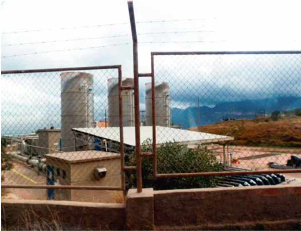
[Fotografía de Romero, J]. (2020). Visual de planta de Biogás. RSDJ, Bogotá, Colombia.
