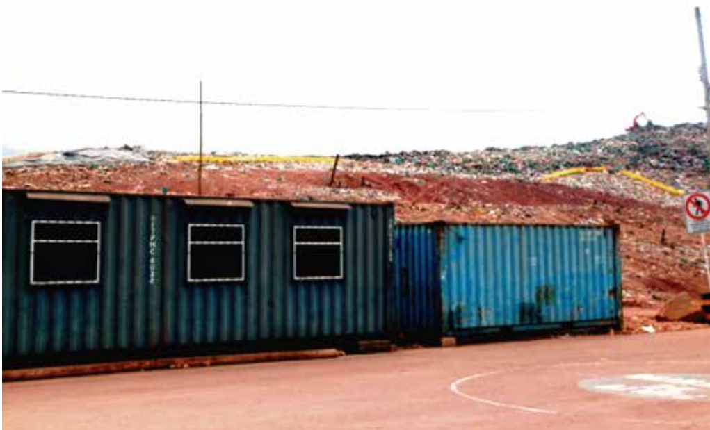
[Fotografía de Romero, J]. (2020). Visual de contenedores de campamento de obra de terraza VIII. RSDJ, Bogotá, Colombia.
