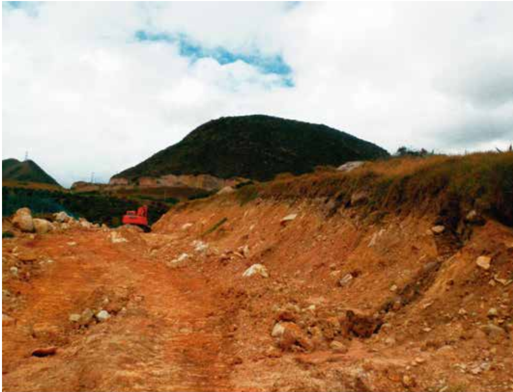
[Fotografía de Romero, J]. (2020). Visual de vía secundaria en adecuación. RSDJ, Bogotá, Colombia.
