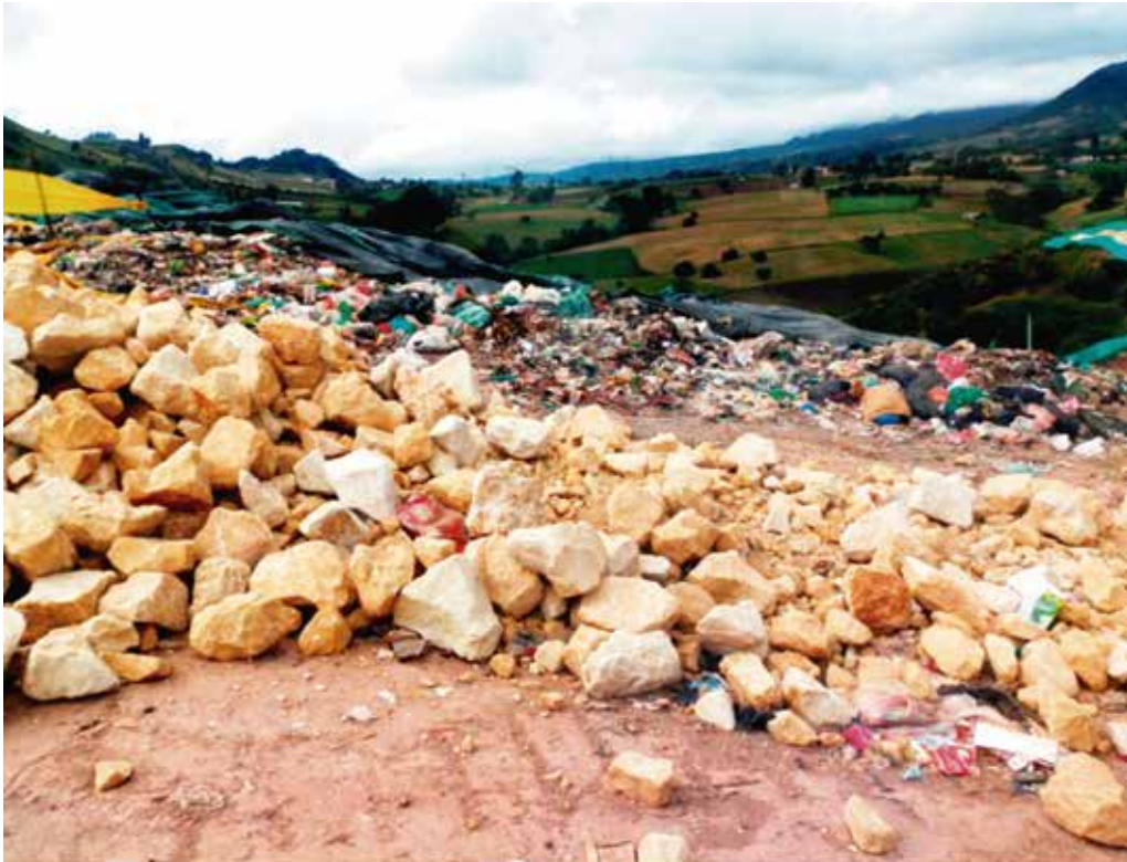
[Fotografía de Romero, J]. (2020). Material para adecuación de capas de celdas, piedra rajón, colocación sobre residuos y capas de plástico. RSDJ, Bogotá, Colombia.
