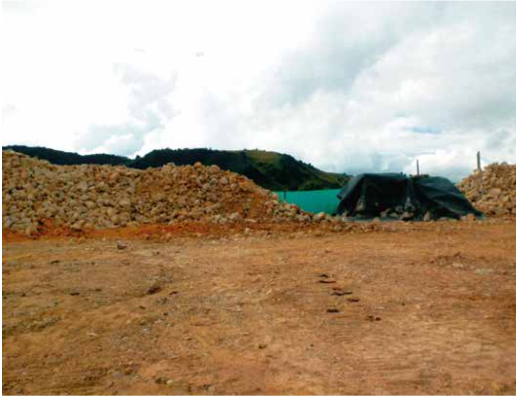
[Fotografía de Romero, J]. (2020). Material para adecuación de capas de celdas, piedra rajón. RSDJ, Bogotá, Colombia.
