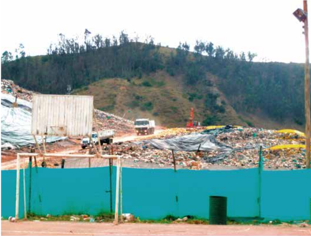
[Fotografía de Romero, J]. (2020). Visual de vaso de disposición final, desde la cancha del campamento de obra. RSDJ, Bogotá, Colombia.
