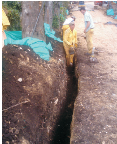
Excavación lineal en forma de zanja para realizar las podas radiculares que puedan afectar la obra
