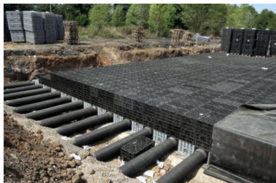
Imagen 7 Tanque almacenamiento Fuente: lineamientos del componente paisajístico EAAB
