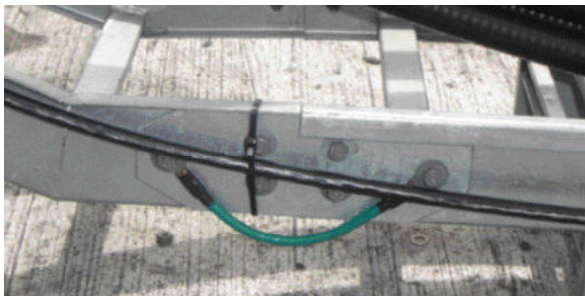
Conductor para continuidad de tierra.
