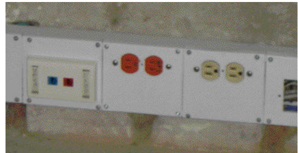
Las salidas se instalarán en canaleta sobre troqueles prefabricados.
