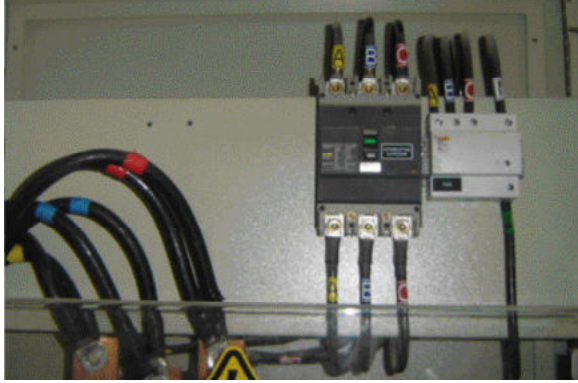
Instalación de dispositivo de protección contra sobretensiones.
