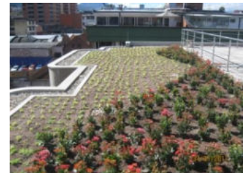
Imagen 10 Techo verde en las instalaciones de la SDA Fuente: SDA
