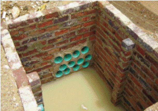
Construcción de estructura en mampostería
