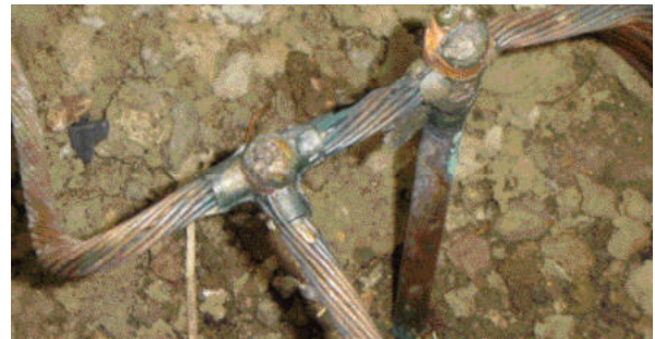
Soldadura exotérmica conexión cable - cable.
