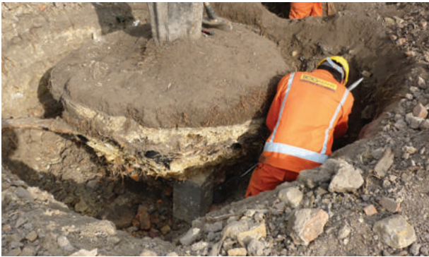
Labores de terminación del bloque
