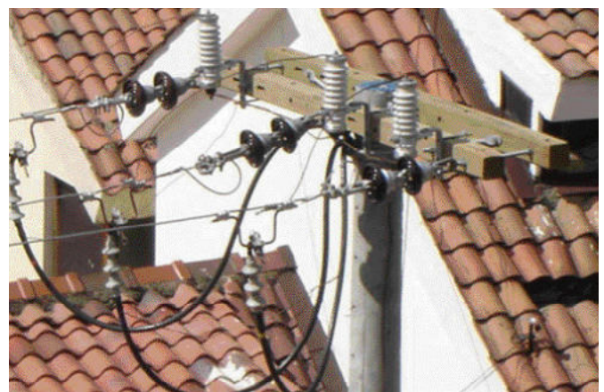
Montaje Típico de estructura de protección en media tensión con pararrayos.
