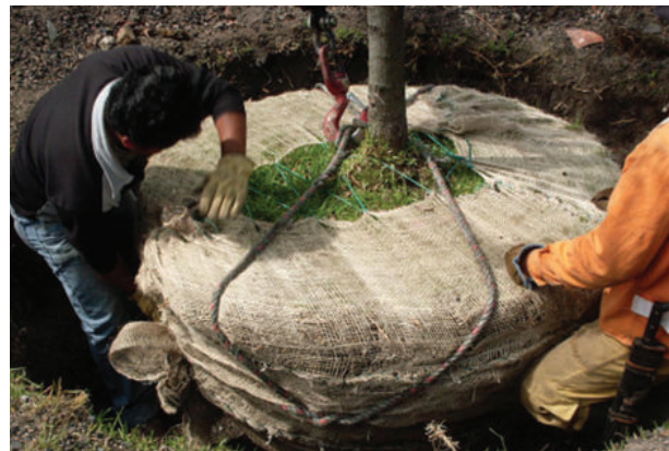
Operarios sujetando el bloque del árbol para su izaje y traslado
