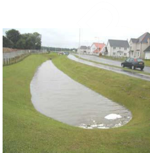
Imagen 14 Cuneta vegetada Fuente: lineamientos del componente paisajístico EAAB
