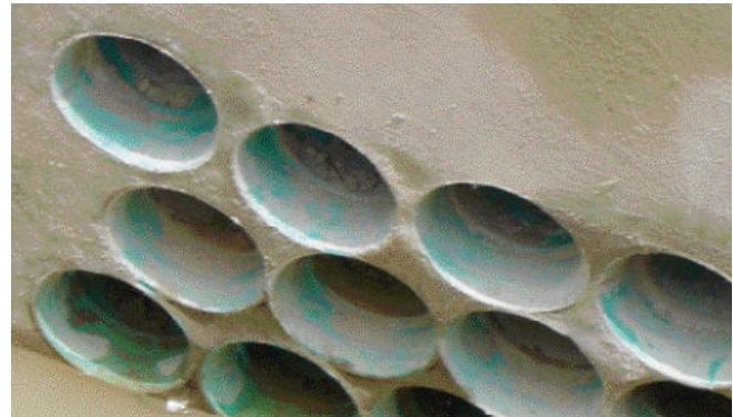
Detalle terminación de ductos con campanas
