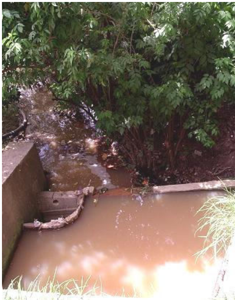
Figura 77. Vertimientos de aguas residuales, aceites, grasas, sedimentos y basuras en descole de colectores pluviales.
