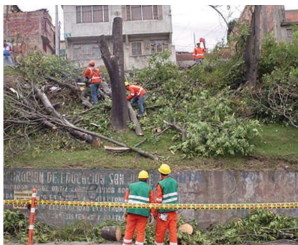
Amarre y corte del fuste principal a nivel del suelo
