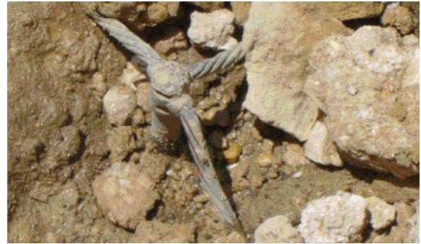
Varilla de puesta a tierra con soldadura exotérmica.
