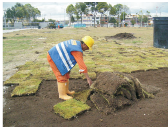
Instalación de cespedones
