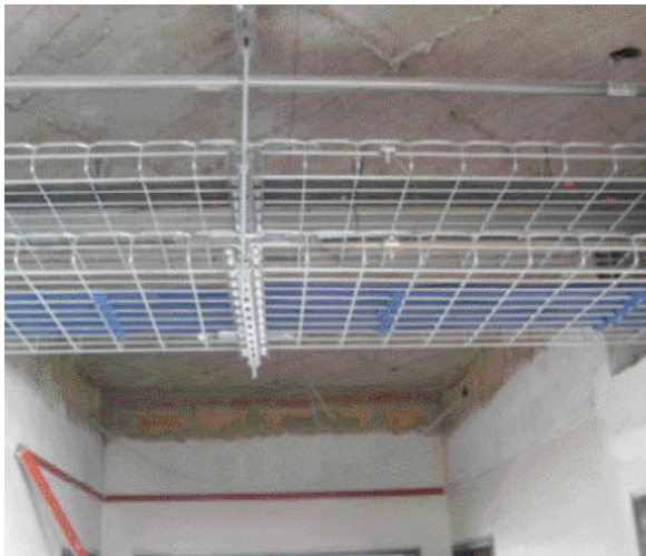
Bandeja portacables tipo rejilla con soportería.
