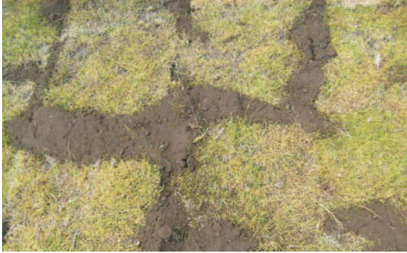
Colocación de tierra negra entre las uniones de los cespedones
