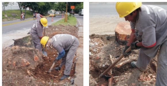
Corte circular alrededor del eje principal del árbol
