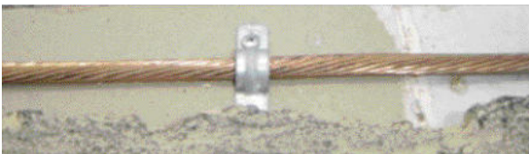
Conductor anillo de apantallamiento.
