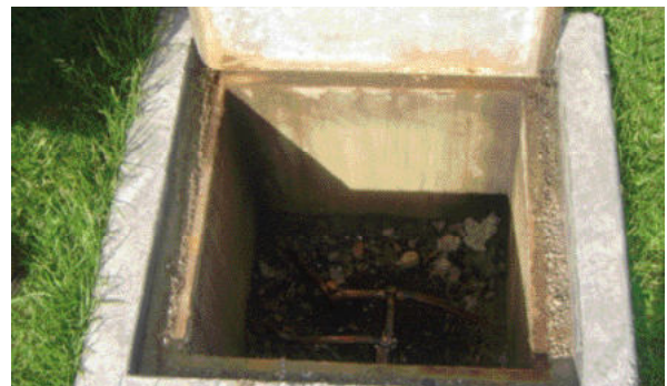
Caja de inspección sistema de puesta a tierra.
