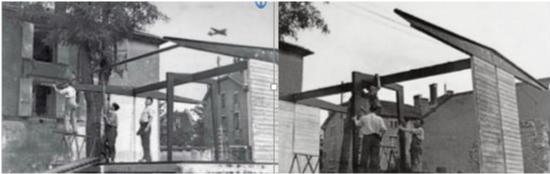
FIGURA 7. Fotos del proceso de montaje.
