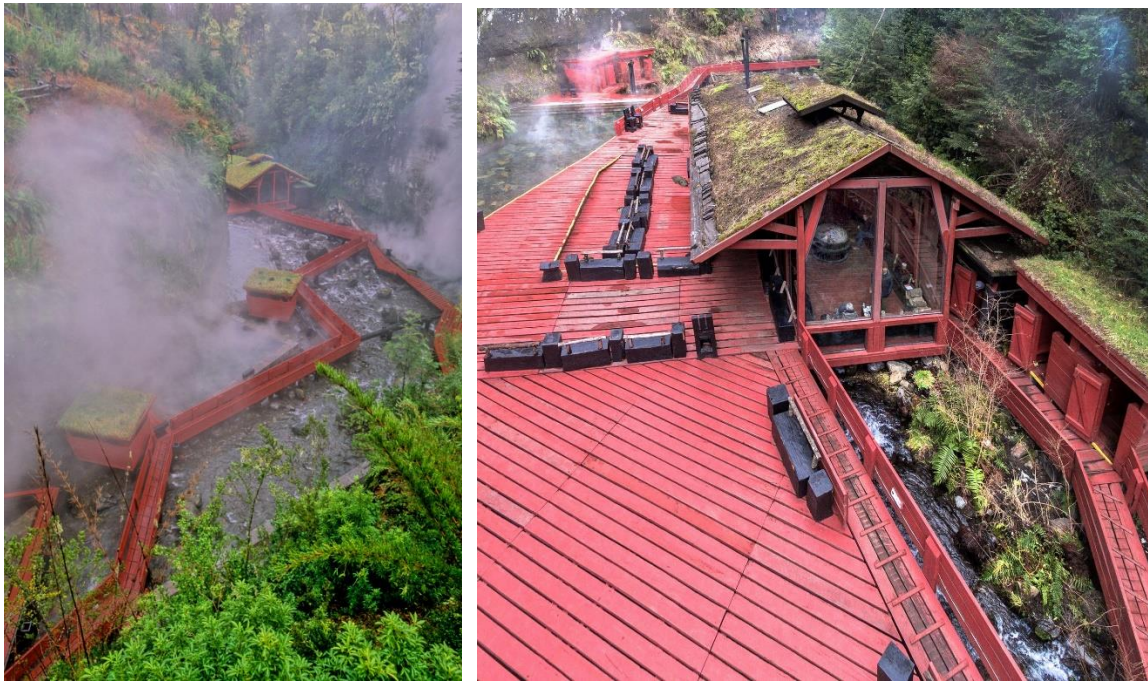
Figura 2: Vista de las termas geométricas, armonía con el paisaje. Tomado de: “Termas geométricas” por G. del Sol. 2009, Recuperado de: Archdaily. https://n9.cl/nahn
