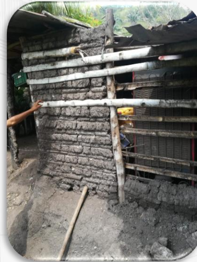
Fuente: Elaboración propia. Pared de bahareque embutido
