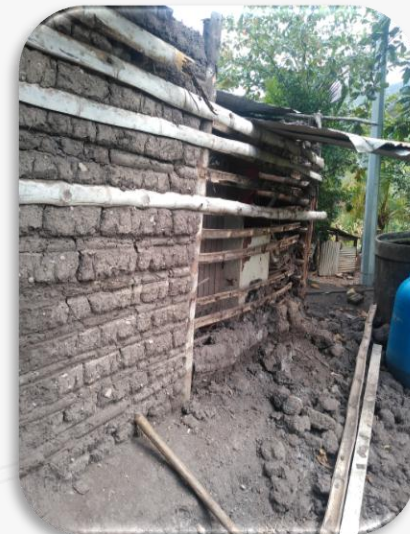
Fuente: Elaboración propia. Pared de bahareque embutido
