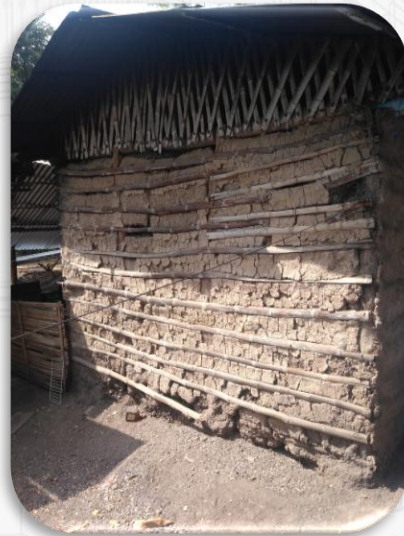
Fuente: Elaboración propia. Pared de bahareque embutido
