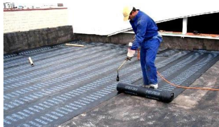
Figura 10 Aislamiento Asfáltico. Tomado de “IMPERMEABILIZACIÓN CON TELA ASFÁLTICA DE TEJADOS Y CUBIERTA” por SONDITEJ,(s.f.). Recuperado de https://sonditej.com/cubiertas-y-tejados-en-bizkaia/impermeabilizacion-con-tela-asfaltica-de-tejados-y-cubiertas-en-bizkaia/
