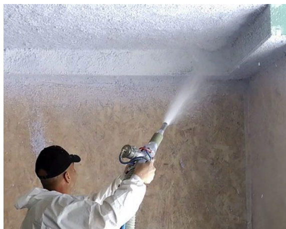
Figura 17 Aísla sismtem. Tomado de “FORMACIÓN DE APLICACIÓN DE AISLAMIENTO PROYECTADO “por AISLASISTEM, (2019). Recuperado de https://www.aislasistem.com/fr/formacion-de-aplicacion-de-aislamiento-proyectado/
