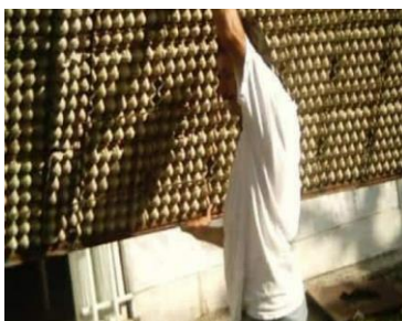
Figura 18 muros constructivos en paneles de huevo. Tomado de “Quindianos recibieron patente por muros con reciclaje” por EL TIEMPO, (2019). Recuperado de https://www.eltiempo.com/colombia/otras-ciudades/arquitecto-quindiano-obtuvo-patente-de-muros-de-reciclaje-415728
