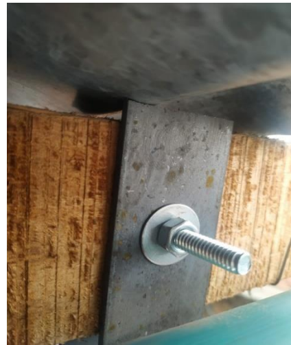
Figura 24 Anclaje de escuadras a correas Elaboración propia.
