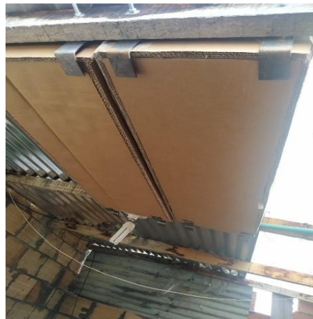
Figura 26 Anclaje de escuadras a correas. Elaboración propia.
