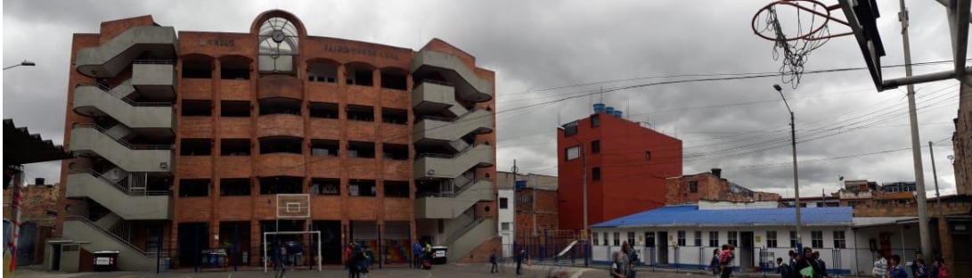
Figura 26. Colegio Técnico Jaime Pardo Leal. Leal Sede preescolar costado derecho de la imagen. Elaboración propia.
