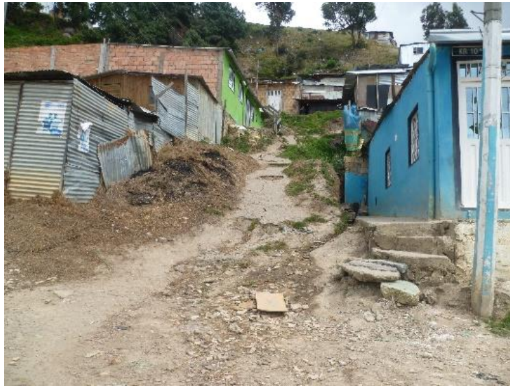
Figura 26. Fotografía Senderos peatonales. Imagen que muestra la falta de senderos y escaleras en el espacio publico. Elaboración Propia.
