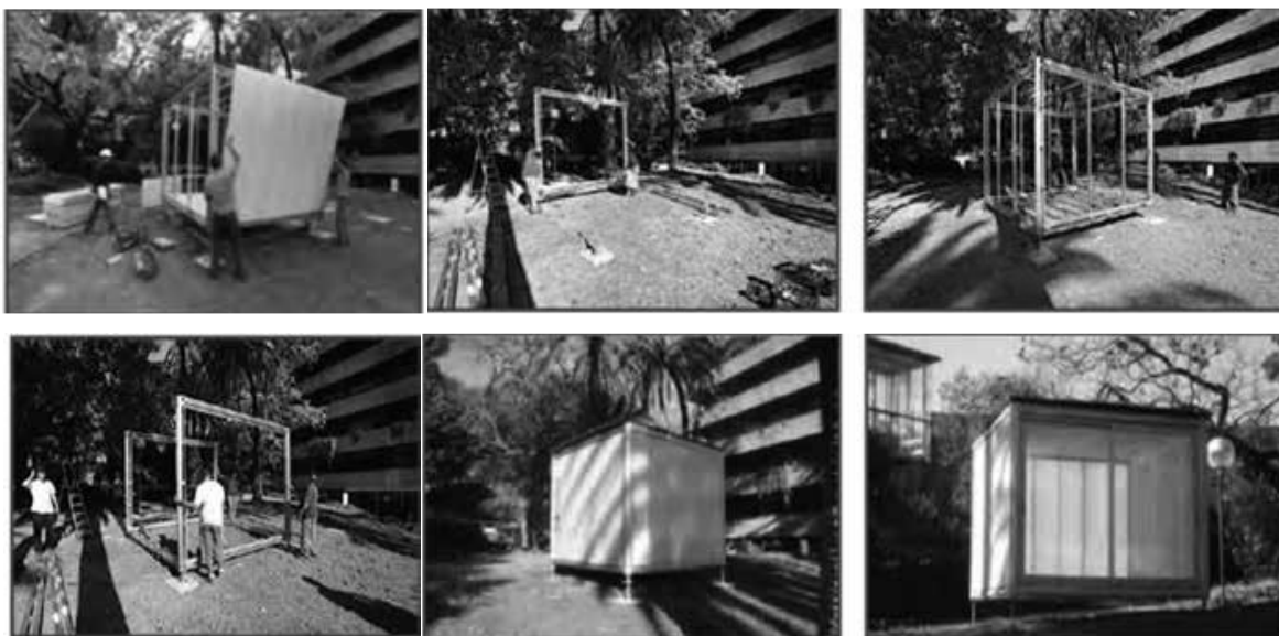
Figura 7. Ejemplo de montaje manual de los componentes. Tomado de Sarmiento, 2017.
