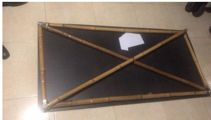
figura 23. Estructura en bambú panel modular con lamina superior en madera contrachapada, elaboración propia
