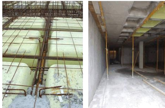
figura 12. Aligeramientos. Se saca el aligerante y dar uso en otra losa. Tomado de https://rodas5.us.es/file/d52ac696-b0f8-1846-8202-5a4cb5dfce14/2/tema12_SCORM.zip/page_10.htm
