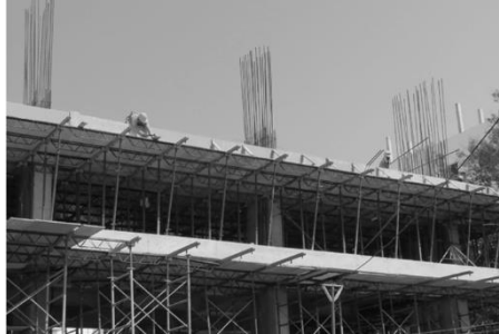
figura 2. Formaletas de encofrado para losas de entrepisos sistema ONUS. Separación de espacios verticales. Tomado de https://www.agrojemur.com/portfolio/formaletas-de-encofrado-para-losas-de-entrepiso-sistema-onus/
