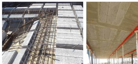
figura 13. Aligeramientos. No se recupera después del vaciar el concreto. Tomado de https://rodas5.us.es/file/d52ac696-b0f8-1846-8202-5a4cb5dfce14/2/tema12_SCORM.zip/page_10.htm
