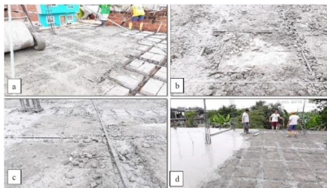
figura 15. Patologías estructurales de los sistemas de losas de entrepiso. Debe ser llenado en una sola etapa para evitar la disgregación del hormigón. Tomado de https://www.researchgate.net/publication/329828855_PATOLOGIAS_ESTRUCTURALES_DE_LAS_LOSAS_DE_HORMIGON_ARMADO
