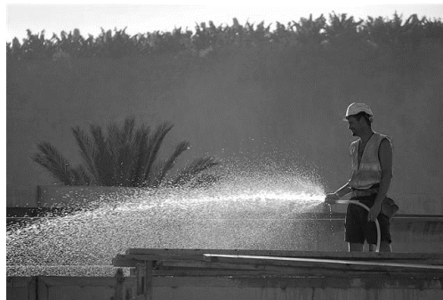
figura 16. Cuidados del hormigón. Mantener la superficie hidratada. Tomado de https://enriquealario.com/curado-de-hormigon/#lightbox/0/
