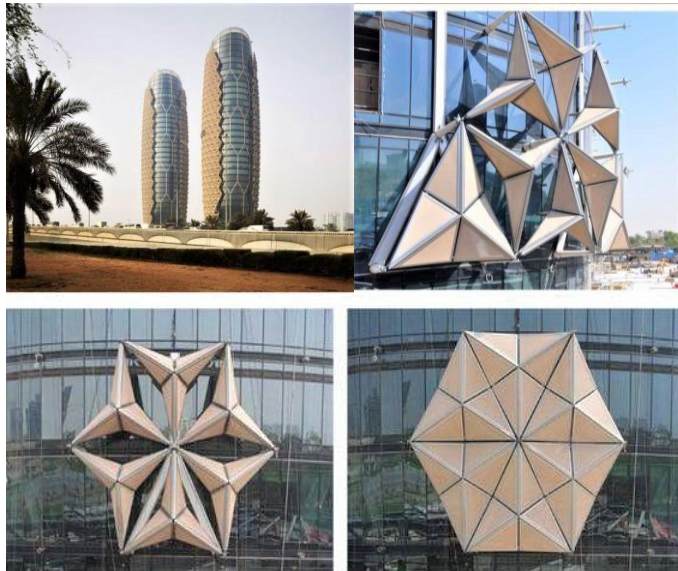
Figura 6. Fachada responsiva. Tomado de: Karanouh, 2012, p. 1.
