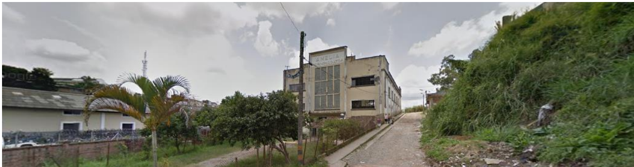
Figura 33 Vista sector Laderas. Tomado de Google Street View. 2019
