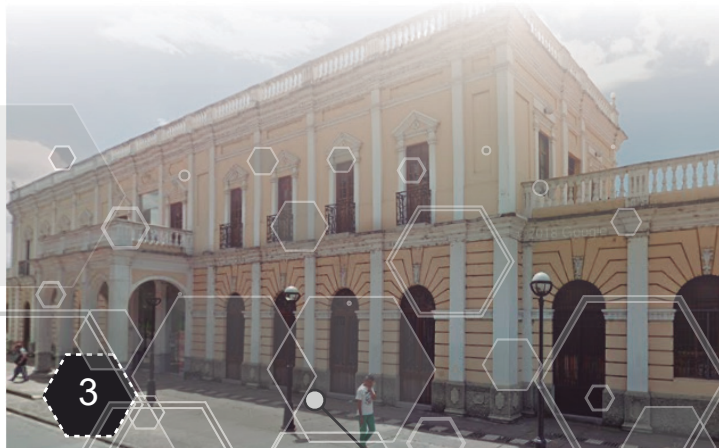
Fuente: Street view
