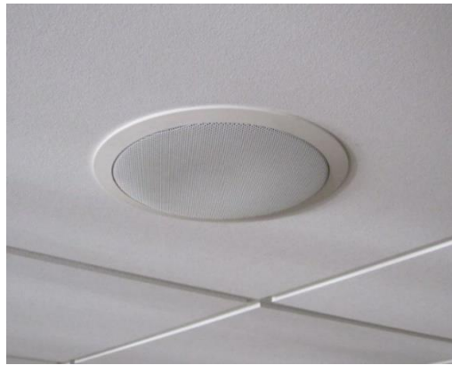
Figura 43. Parlantes a nivel de techo
