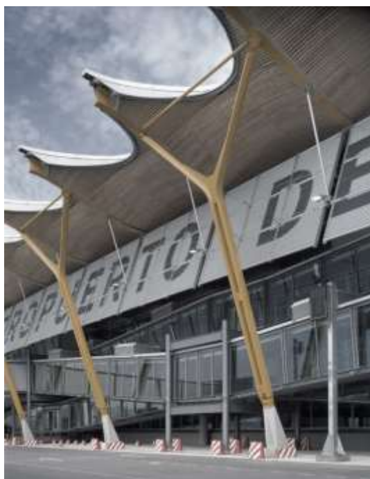
Figura 14. imagen lateral del aeropuerto Barajas
