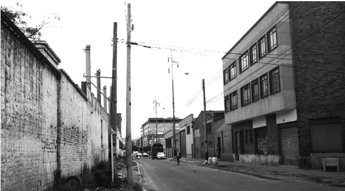
Figura 31-Fachada lateral de la Estación -abandono y pérdida de identidad
