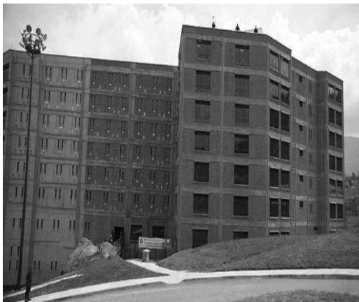
figura 11 Complejo carcelario y penitenciario de Medellín, Construidos a finales de los 2000. Elaborado por pedregal-INPEC
