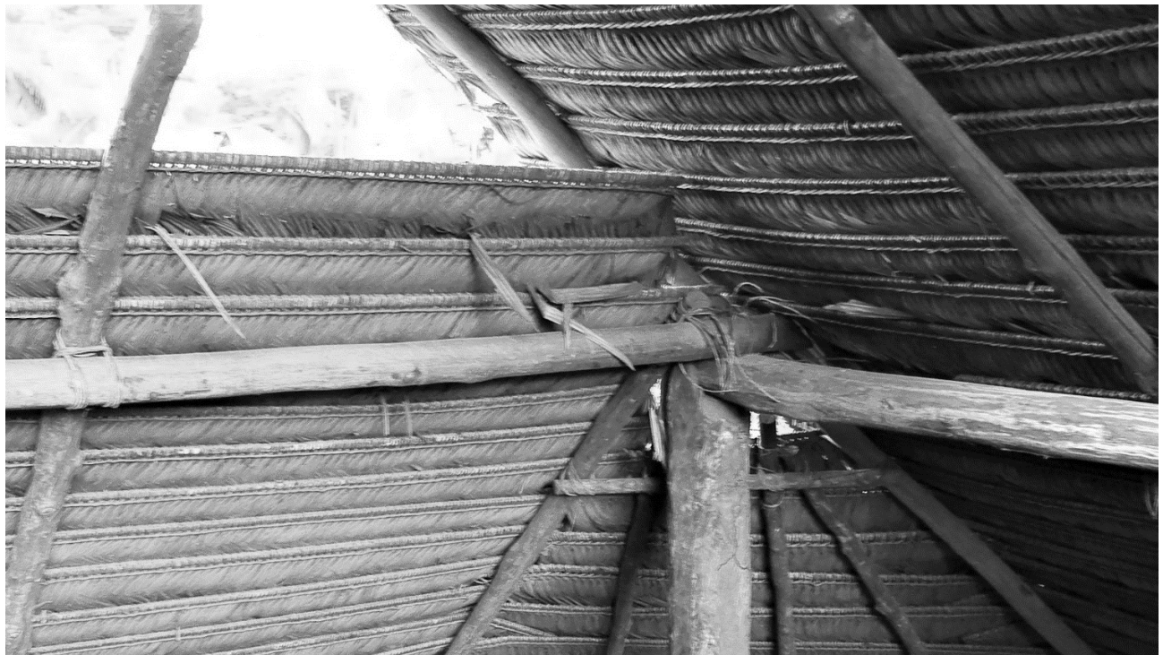
Figura 19. Soleras y Estantillos. Apoyos y amarre de elementos principales de la estructura de la maloca. Elaboración propia.
