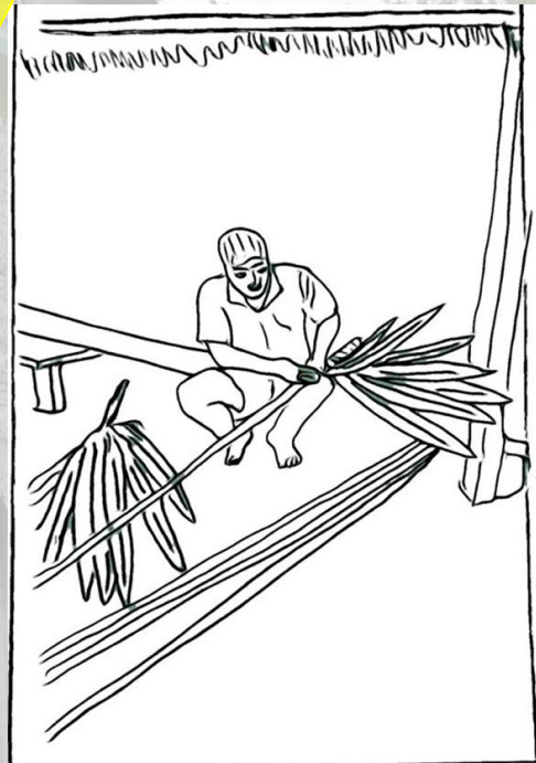
Tejido de los paños con la palma de caraná para la cubierta.
