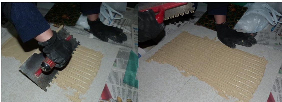
Figura 29 Mezcla de pegacor. Este producto se debe mezclar con la finalidad de que no presente ningún grumo, para que logre la instalación adecuada, la mezcla debe ser espesa, no puede ser muy líquida y que puede que la baldosa no pegue correctamente. Elaboración propia.
