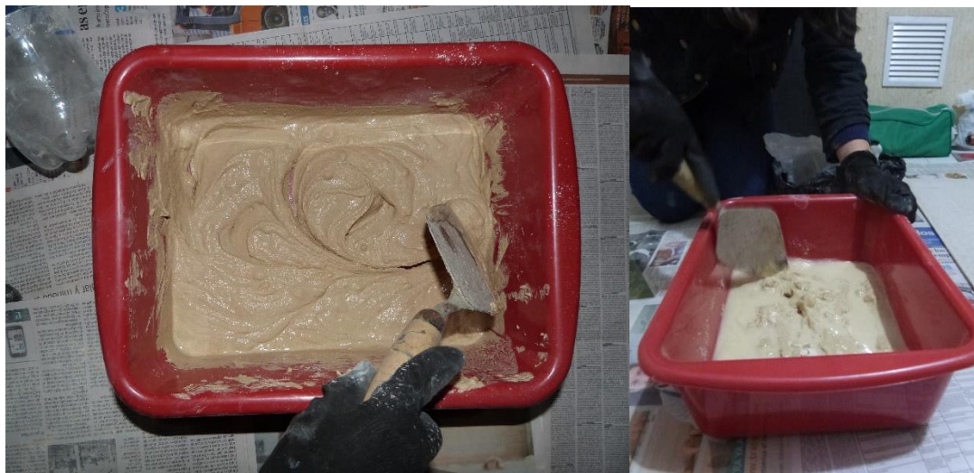
Figura 29 Mezcla de pegacor. Este producto se debe mezclar con la finalidad de que no presente ningún grumo, para que logre la instalación adecuada, la mezcla debe ser espesa, no puede ser muy líquida y que puede que la baldosa no pegue correctamente. Elaboración propia.
