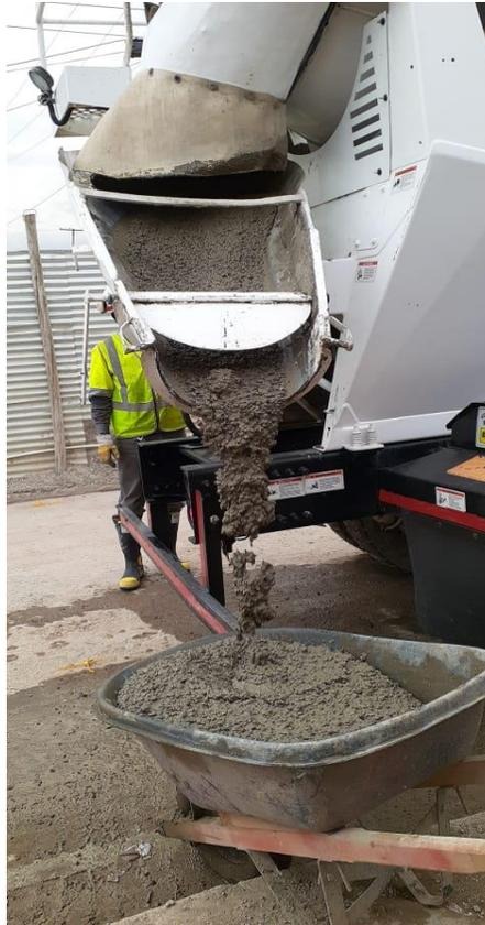
*Figura No. 21. Vaciado Concreto estructural*
