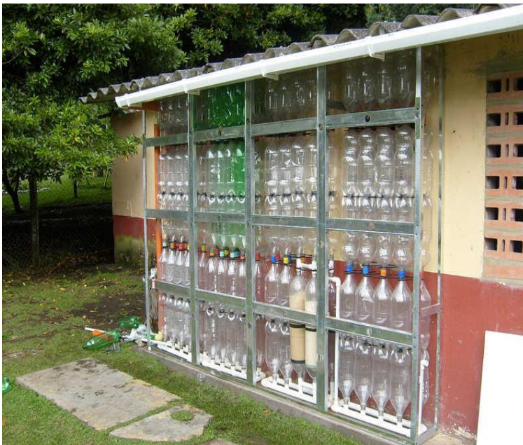
[Fotografía de Ecoinventos]. (2018). Ekomuro H2O+. Tanque modular vertical para almacenar agua lluvia reutilizando botellas PET. Recuperado de https://bit.ly/2JkTWAB
