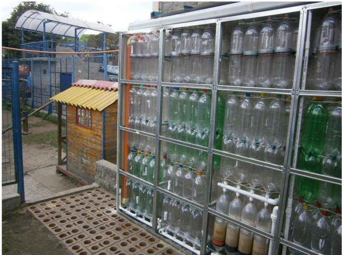
[Fotografía de Ecoinventos]. (2018). Ekomuro H 2 O+.Tanque modular vertical para almacenar agua lluvia reutilizando botellas PET. Recuperado de https://bit.ly/32TS6xB
