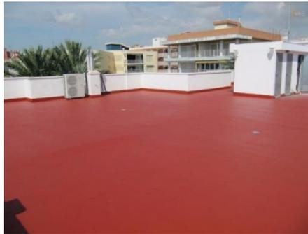
*Figura 15 Membrana líquida impermeabilizante expuesto por Sika(s.f.) Recuperado de <https://col.sika.com/>*
