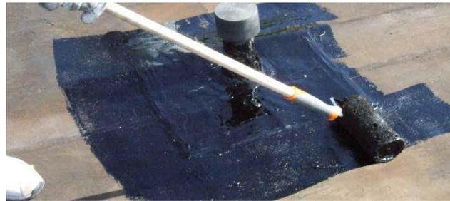
*Figura 16 Recubrimiento con materiales bituminosos expuesto por Archiexpo (2018) Recuperado de <https://www.archiexpo.es/>*
