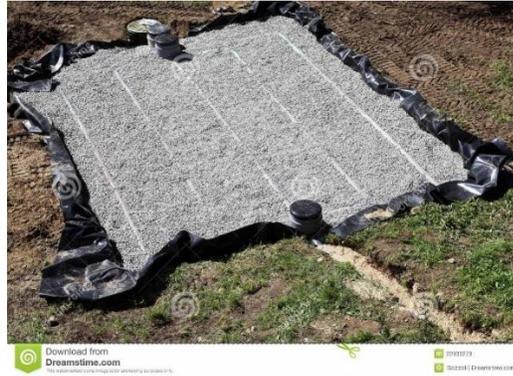
*Figura 13 Capa filtrante expuesto por Canexel (2014) Recuperado de <https://www.canexel.es/>*
