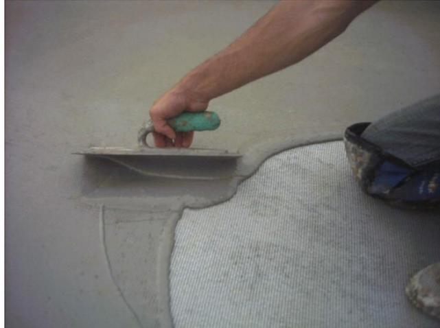
*Figura 14 Impermeabilización de cemento expuesto por Duran (2015) Recuperada de <https://www.albaniles.org/albanileria/como-aplicar-cemento-elastico-para-impermeabilizar-terrazas-y-techos/>*
