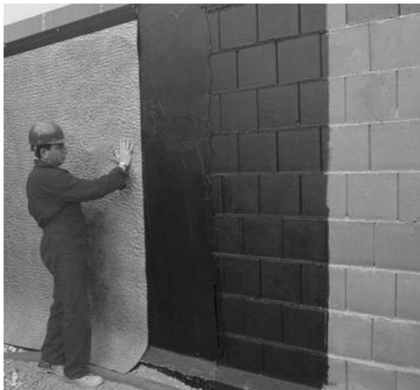
*Figura 5* Impermeabilización de muros. Tomado de Impermeabilizaciones Económicas
