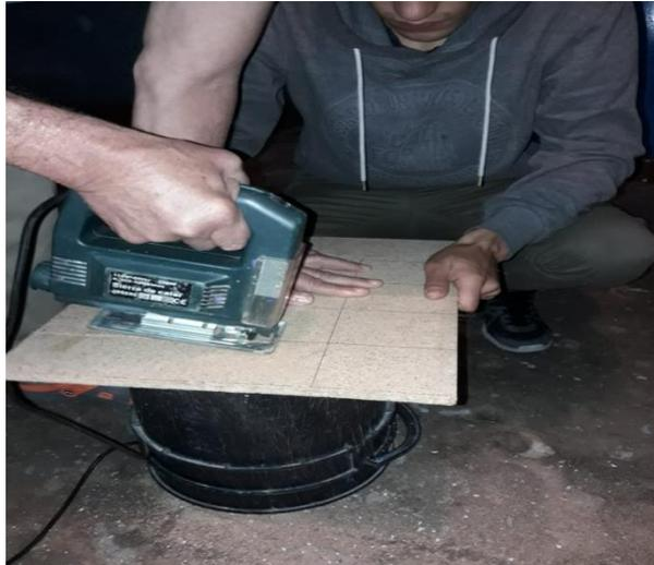
*Figura 16* Trazado y Corte y de los moldes en tablero aglomerado. Elaboración propia
