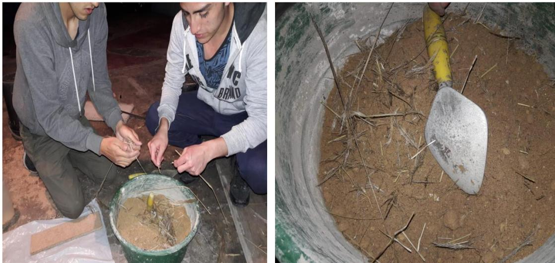
*Figura 25 y Figura 26 Mezcla de tierra, arena y paja. Elaboración propia*
