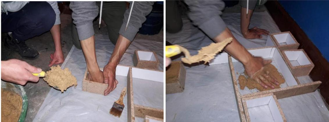
*Figura 29 y Figura 30* Vertimiento de la mezcla en los moldes. Elaboración propia
