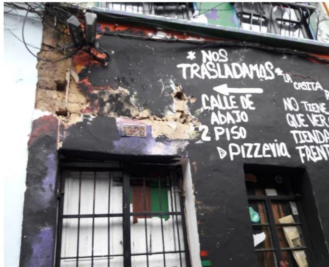
*Figura 11* Erosión de material en fachada y muro de la localidad la candelaria. Elaboración propia
