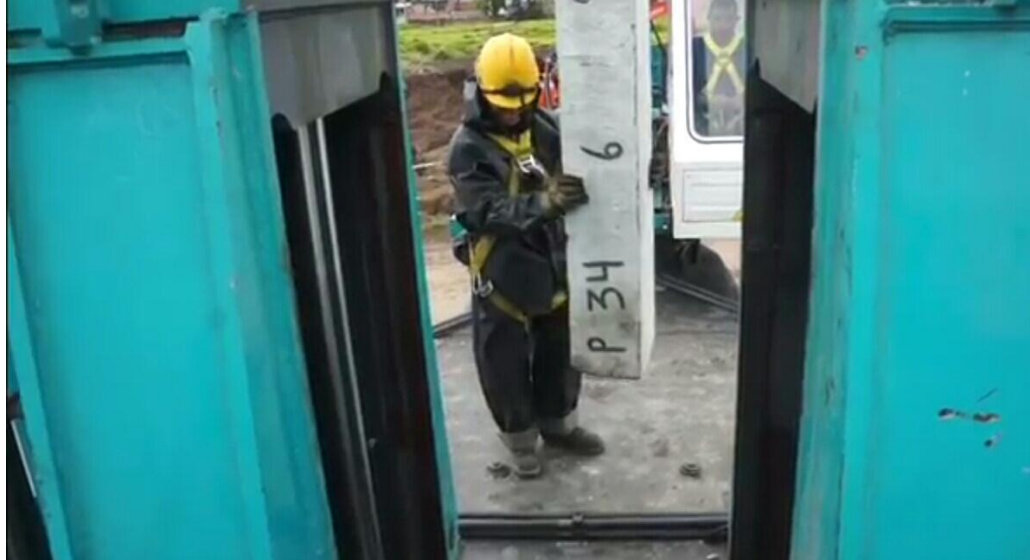
Imagen 21. Ubicación del pilote según planos y topografía.
