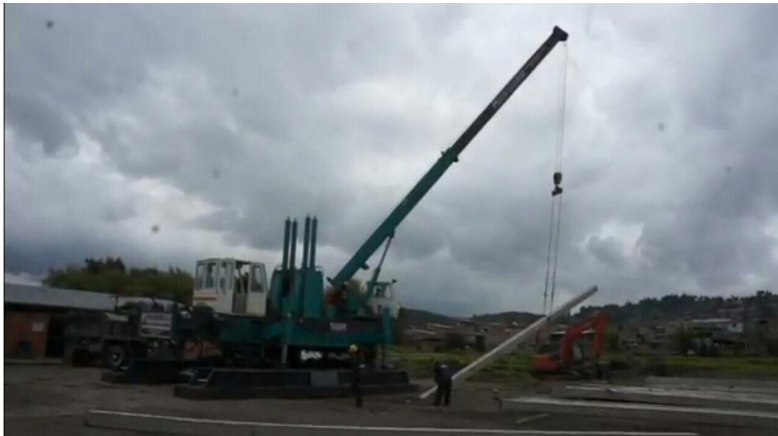
Imagen 20. Izado de pilotes prefabricados.
