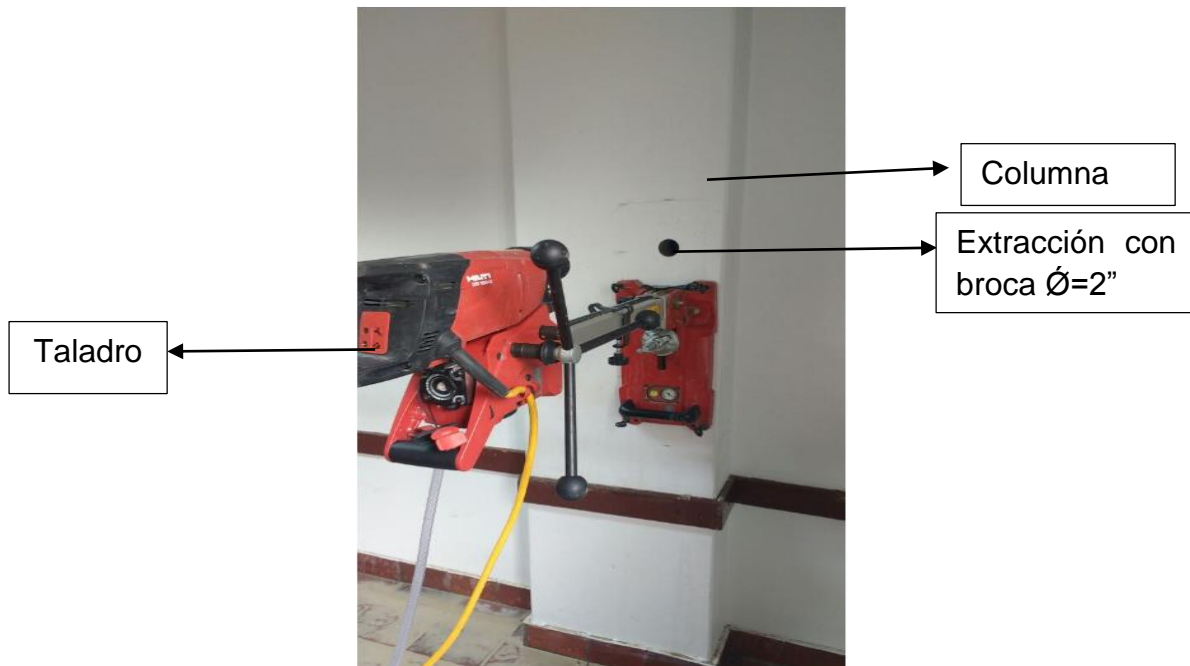
Figura 6. Taladro extractor de núcleos HILTI DD-150
