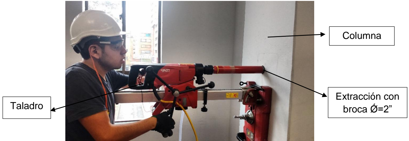
Figura 7. Procedimiento extracción de núcleos.
