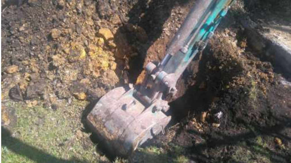
Ilustración 1 Excavación para obtener muestra de suelo fino.
