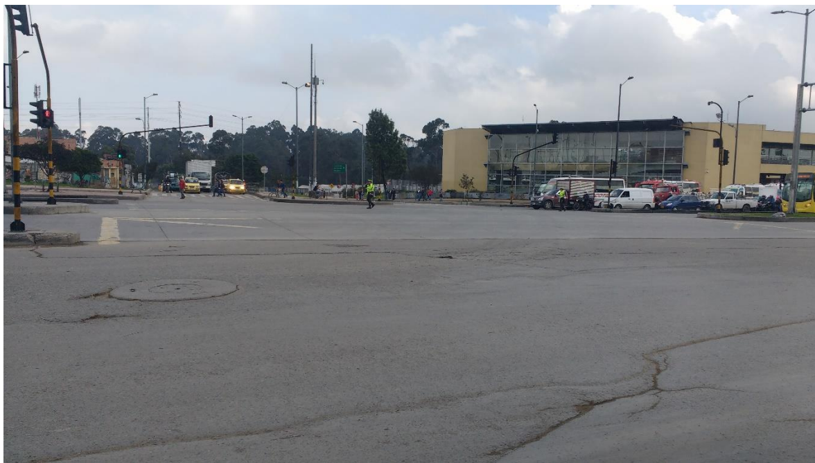
Ilustración 4 Estado actual de la vía
