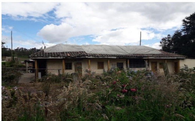
Fotografía 2-5: Vivienda campesina en la localidad de Usme
