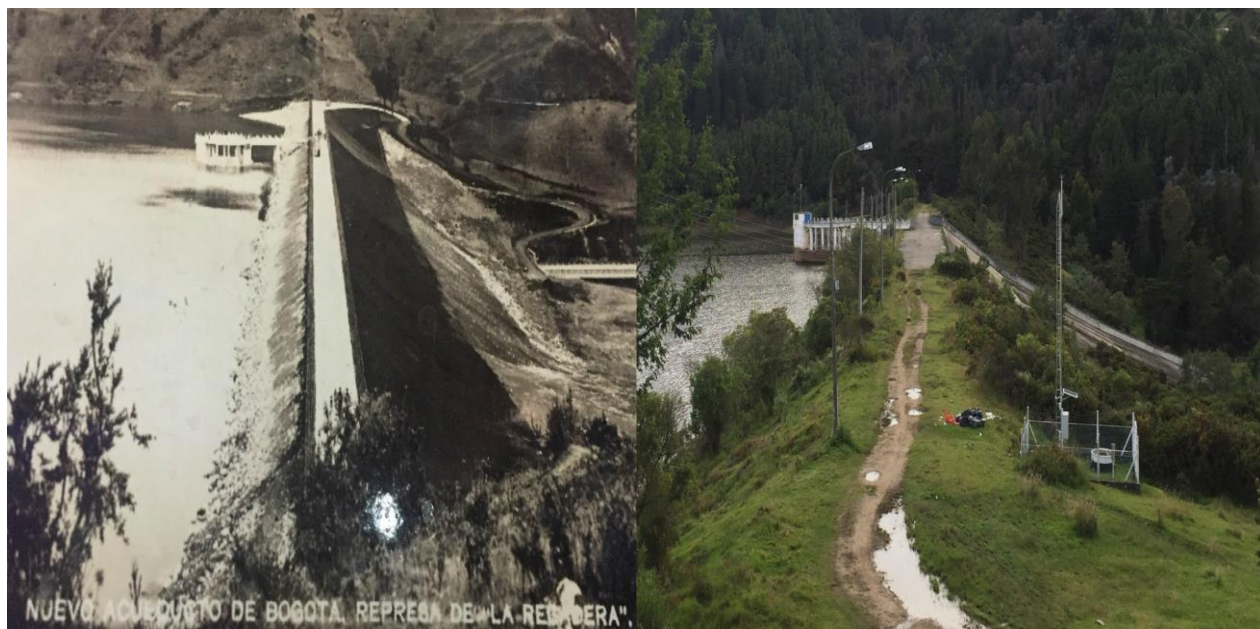
Imagen 0-1: Comparativo del terraplén en el embalse de La Regadera
