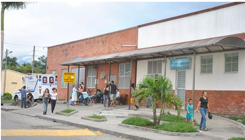
Ilustración 4. Fotografía del E.S.E Hospital Pío X Fuente: La Crónica del Quindío, 2015.
