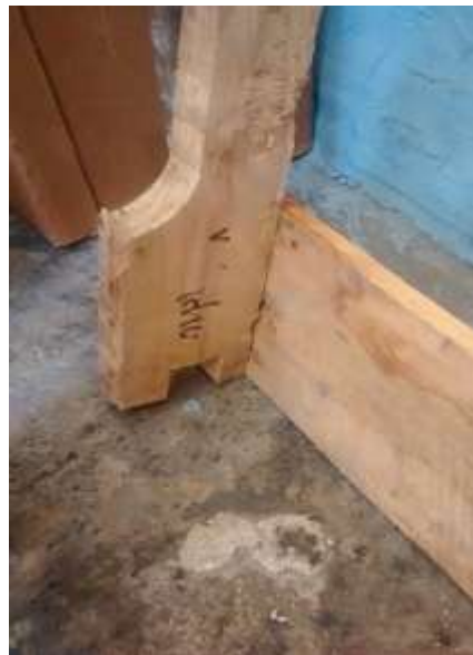
Ilustración 21: Caja para empalme con viga de piso
