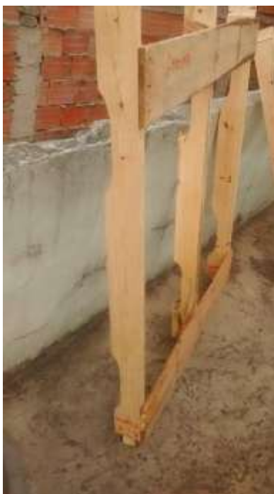
Ilustración 23: Tabla de arriostramientos y empate en espigo
