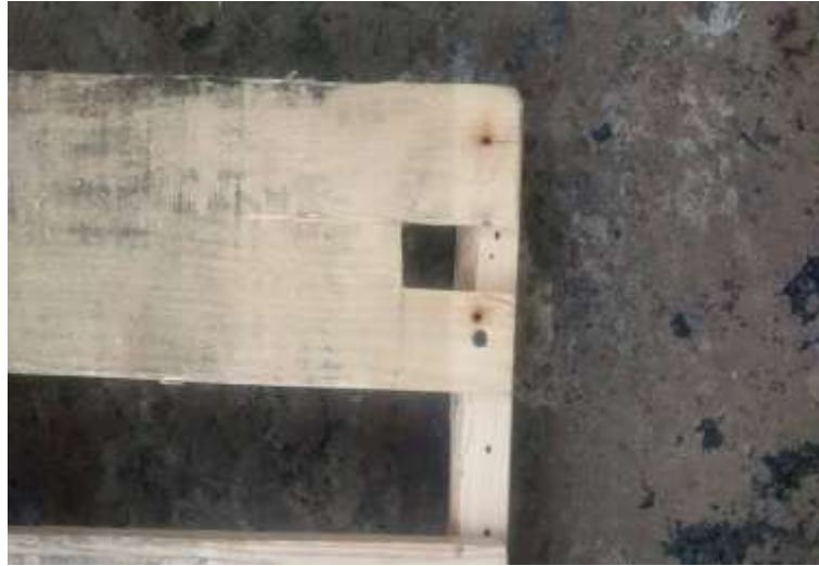
Ilustración 20: Fijación para esquina
