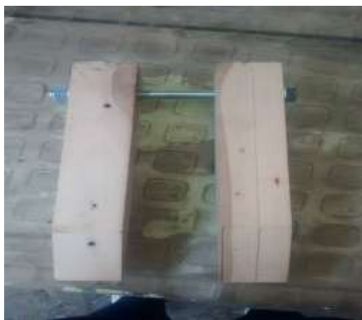
Ilustración 17: Tornillo pasante para unión a viga de piso
