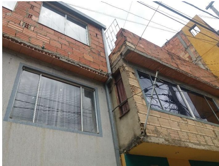
Figura 21. Cubierta terraza construida con bloquelones sin perfiles estructurales Placa Fácil Fuente: Propia.
