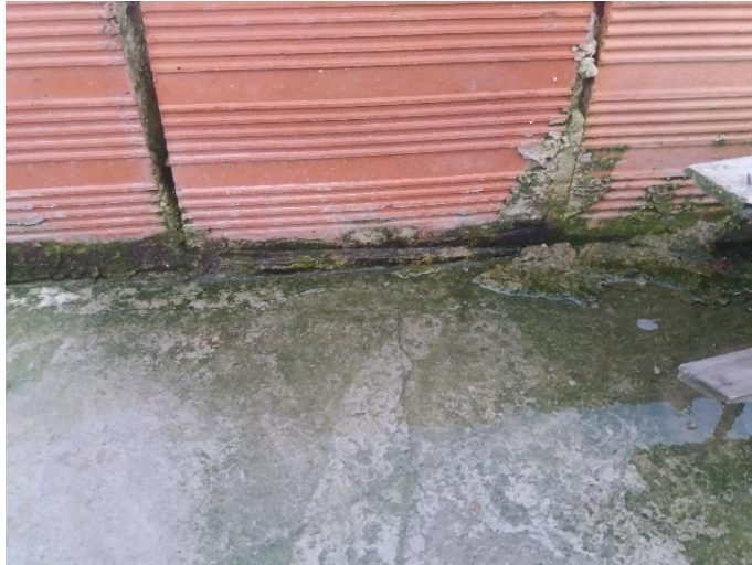
Figura 23. Origen de moho por concentración de agua lluvia Fuente: Propia.
