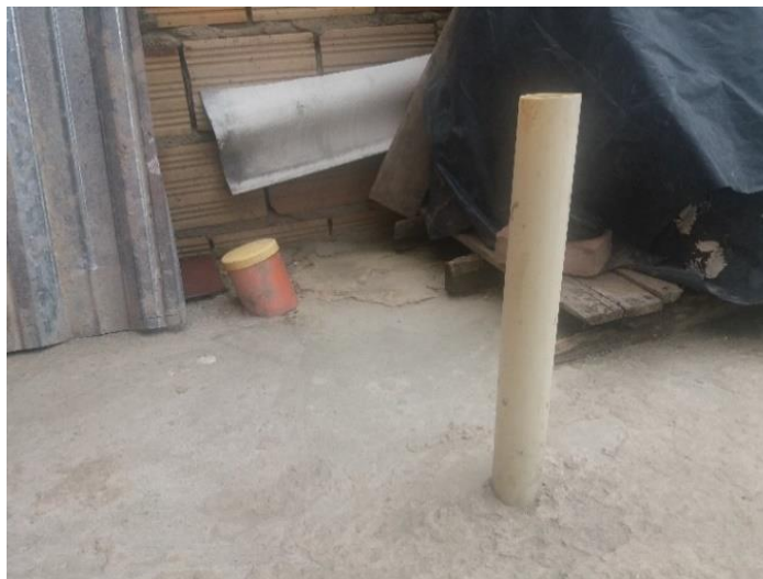
Figura 28. Instalaciones a la intemperie Fuente: Propia.
