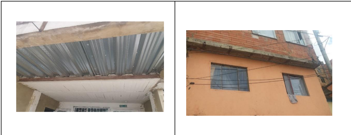
Figura 17. Vivienda informal con terraza en Steel Deck y Placa Fácil Fuente: Propia
