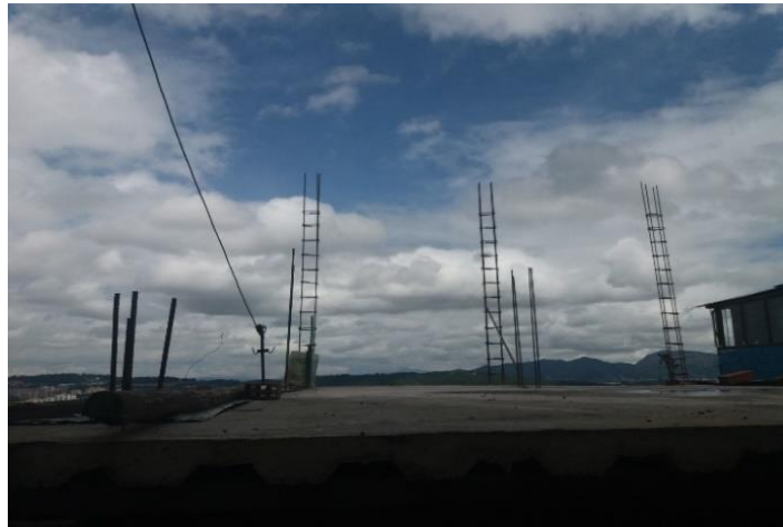
Figura 27. Anclajes para futura construcción Fuente: Propia.
