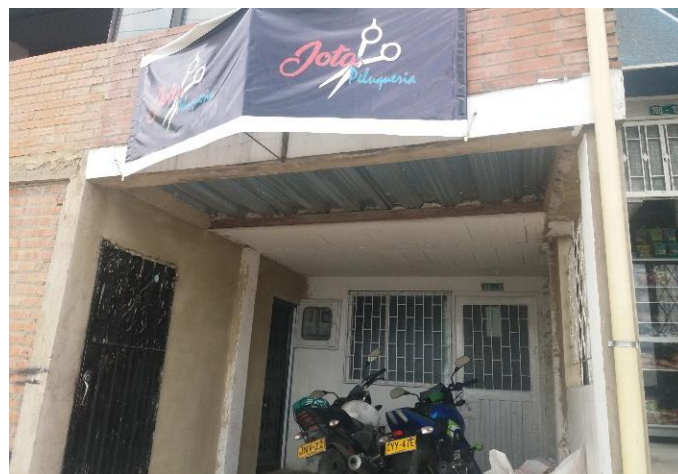
Figura 18. Vivienda de uso comercial con unión de sistemas constructivos Fuente: Propia
