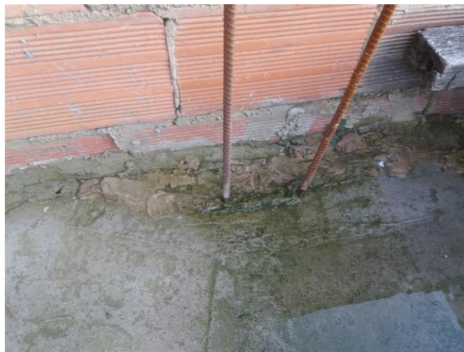
Figura 23. Origen de moho por concentración de agua lluvia Fuente: Propia.
