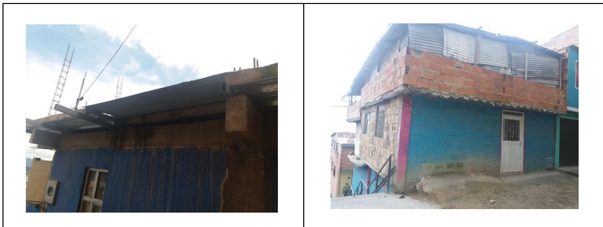
Figura 16. Vivienda informal con terraza en Steel Deck Fuente: Propia
