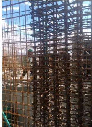
*Ilustración 31 Refuerzo esquinas de los muros*
