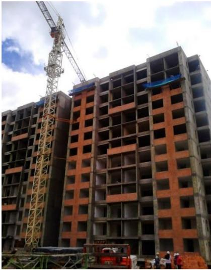
El proyecto se encuentra ubicado en la Cra. 87 #17-59, Bogotá, hoyuelos, son apartamentos de 12 pisos. El sistema se caracteriza por la prefabricación de muros, por ende, su nombre es I.C paneles, el cual tiene 14 m<sup>2</sup> por torres.
