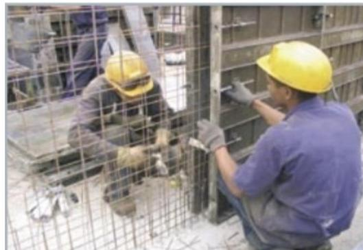
Ilustración 8 Refuerzo de muro
