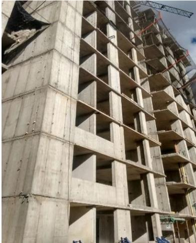
formesan: Esta obra está ubicada entre biblioteca Tintal y la Cali. Se compone de torres de vivienda multifamiliar. Para esta obra se usó Formesan, un sistema industrializados con formaletas de aluminio mano portables, que permiten fundir monolíticamente muros con losas de entrepiso, y una rápida rotación debido al concreto acelerado que se emplea para realizar dos viviendas diarias.
