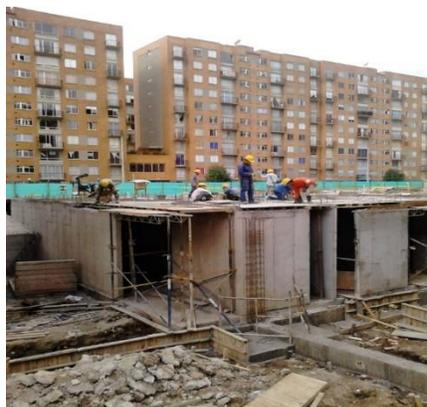
*Ilustración 37 Muros prefabricados*
