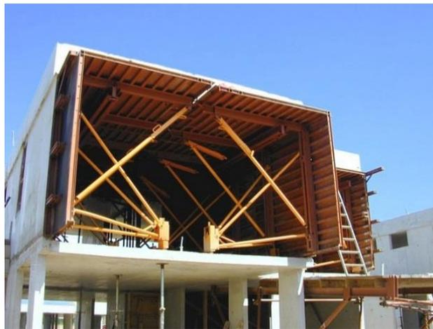
*Ilustración 14 Sistema túnel, outinord.*
