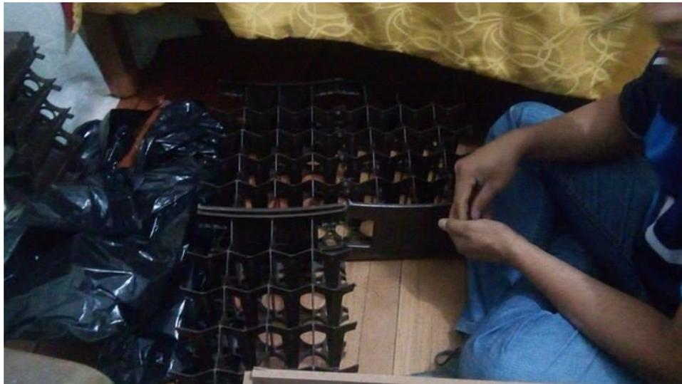
Ilustración 33. Anclaje lateral entre retículas sobrantes del corte original Fuente: Elaboración Propia (2015)
