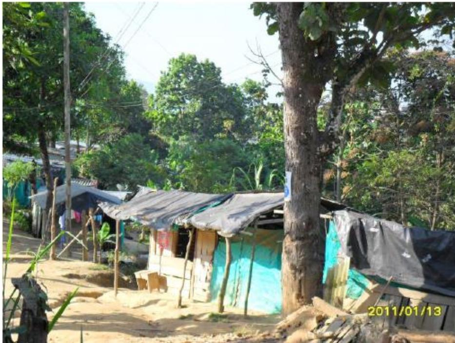
Ilustracion 4. Se puede observar un tipo de albergue construido en material de polisombra y perfiles en madera para una Fuente: (Cardenas J., 2012) *Alternativa de albergue temporal en estructuras metalicas desarmables basadas en las lecciones aprendidas en la construccion de unidades metalicas moviles para oficinas* p.13 (Consultado 8/09/2015). Recuperado de <http://goo.gl/YCvY0f>
