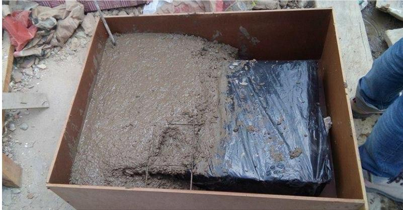
Ilustracion 36. Se observa el prototipo de placa aligerada con reticula de canasta de cerveza cubierta por plástico de alta densidad Fuente: Elaboracion Propia (2015)
