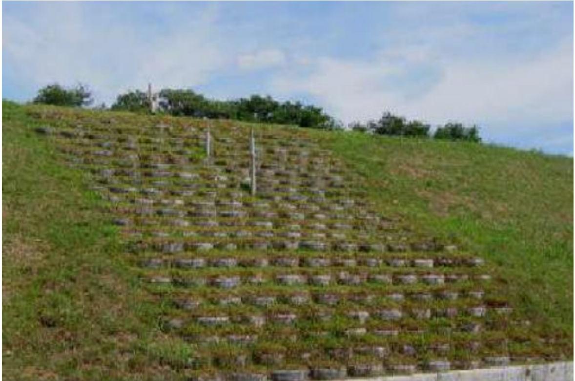
Figura 1. Vista general de la obra desarrollada con llantas de refuerzo utilizada para la investigación.
