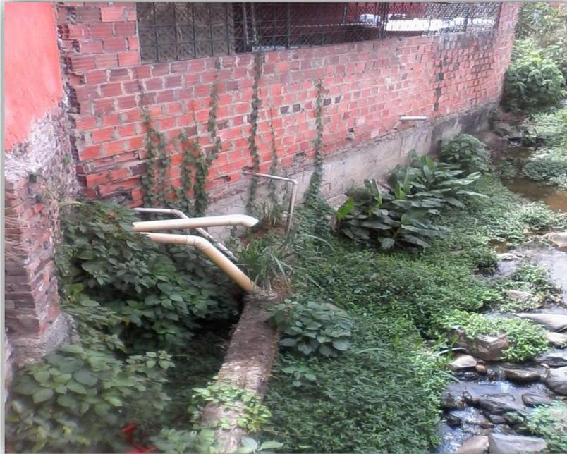
Ilustración 34 conexiones prohibidas del sistema de alcantarillado
