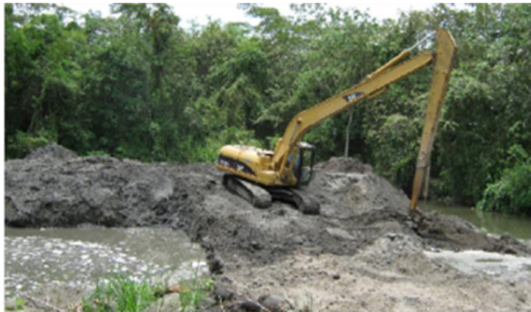
Ilustración 4. Excavación y movimiento de tierras – Usocoello
