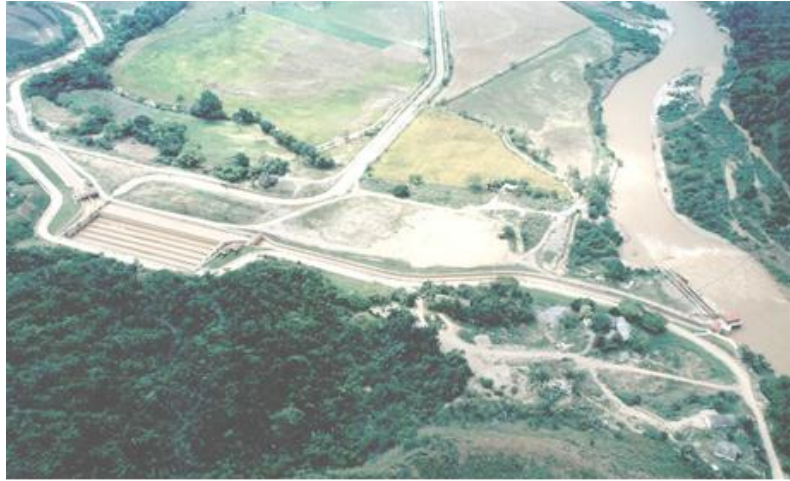
Ilustración 3. Obras de Captación Rio Coello – Usocoello Tomado de: http://www.usocoello.com/portafolio/historia.php
