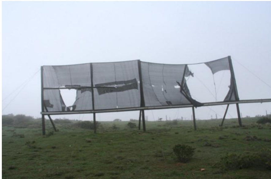
Figura 4: Ruptura de malla colector Peña Blanca-Chile.
