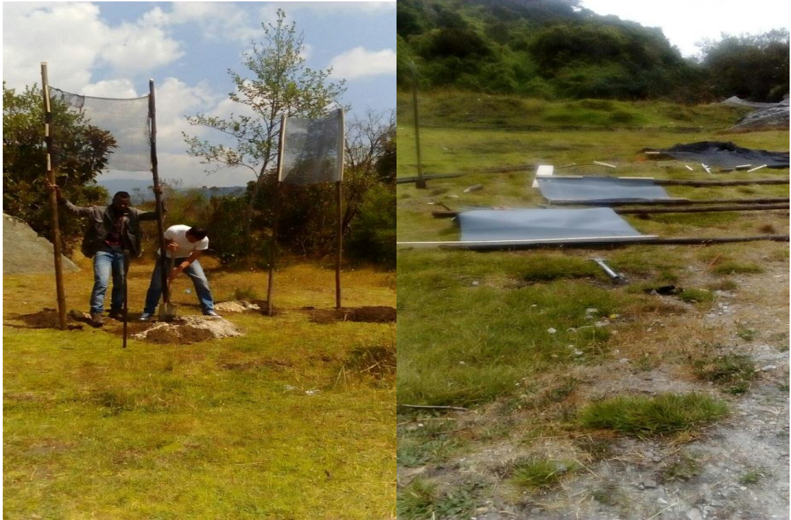
Figura 15: Proceso de instalación Neblinómetros
