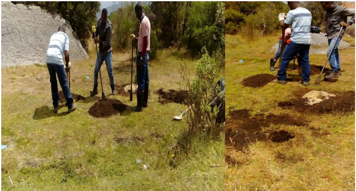
Figura 14: Proceso de instalación Neblinómetros
