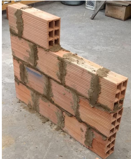
Figura 26: Construcción de muro en el método tradicional. Elaboración propia.
