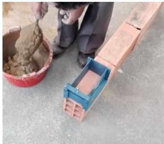
Figura 27: Llenado de tolva del deslizador de mortero. Elaboración propia.
