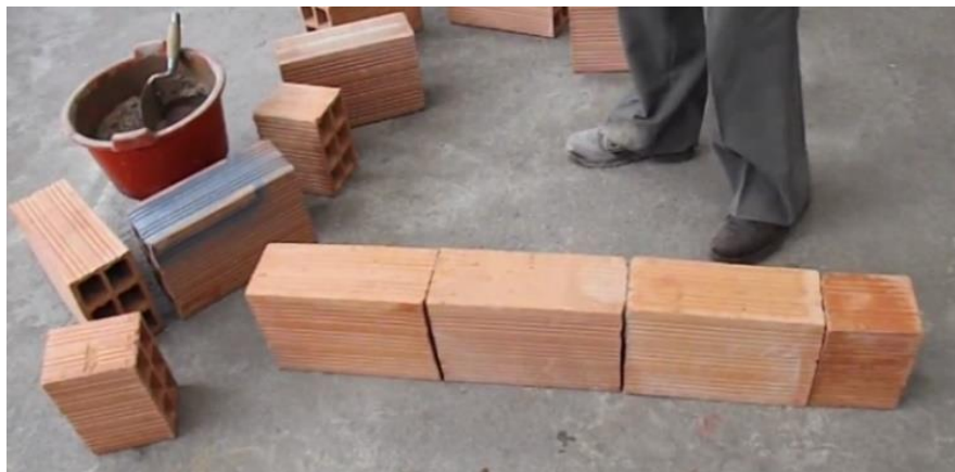
Figura 23: Primera hilada de bloque en el método tradicional. Elaboración propia.
