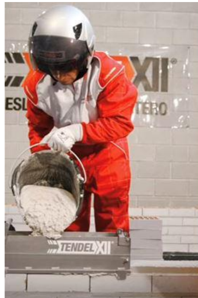
Figura 7: Tendel XII. 2012. Vertido del mortero. Tomado de “Tendel XII” por Tendel XII, 2016, recuperado de https://www.tendel12.com/es/
