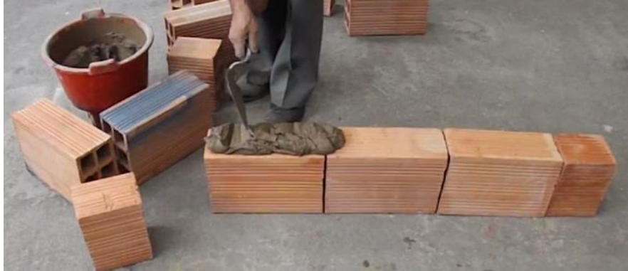
Figura 24: Aplicación del mortero de pega en el método tradicional. Elaboración propia.
