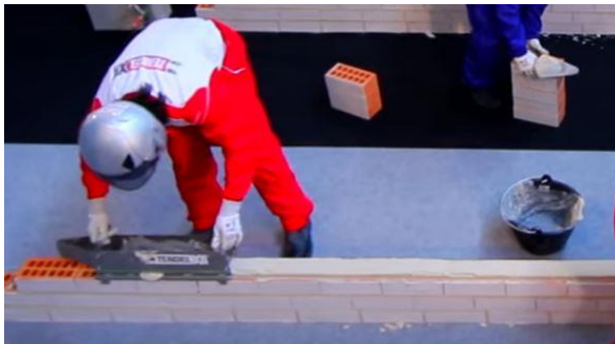
Figura 8: Tendel XII. 2012. Aplicación de la junta de mortero. Tomado de “Tendel XII” por Tendel XII, 2016, recuperado de https://www.tendel12.com/es/
