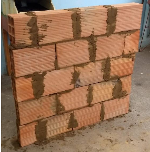
Figura 30. Muro construido con el deslizador de mortero. Elaboración propia.
