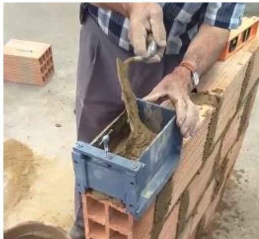
Figura 29: Colocación de la mezcla de mortero en el deslizador de mortero. Elaboración propia.
