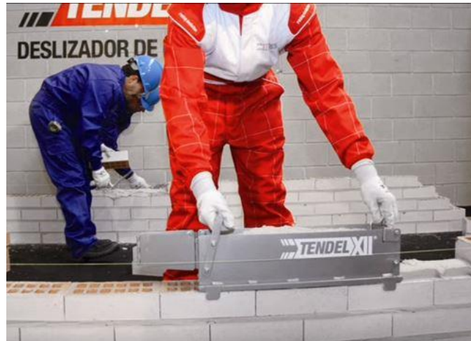
Figura 6: Tendel XII. 2012. Colocación de la herramienta. Tomado de “Tendel XII” por Tendel XII, 2016, recuperado de https://www.tendel12.com/es/
