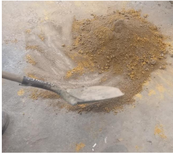
Figura 22: Preparación de mortero de pega. Elaboración propia.
