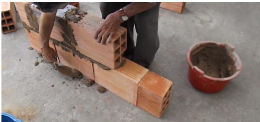
Figura 25: Emboquillado de mampostería en el método tradicional. Elaboración propia.
