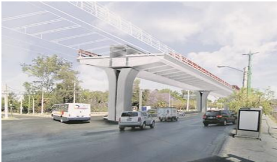
Imagen 5. Puente se sistema de transporte masivo
