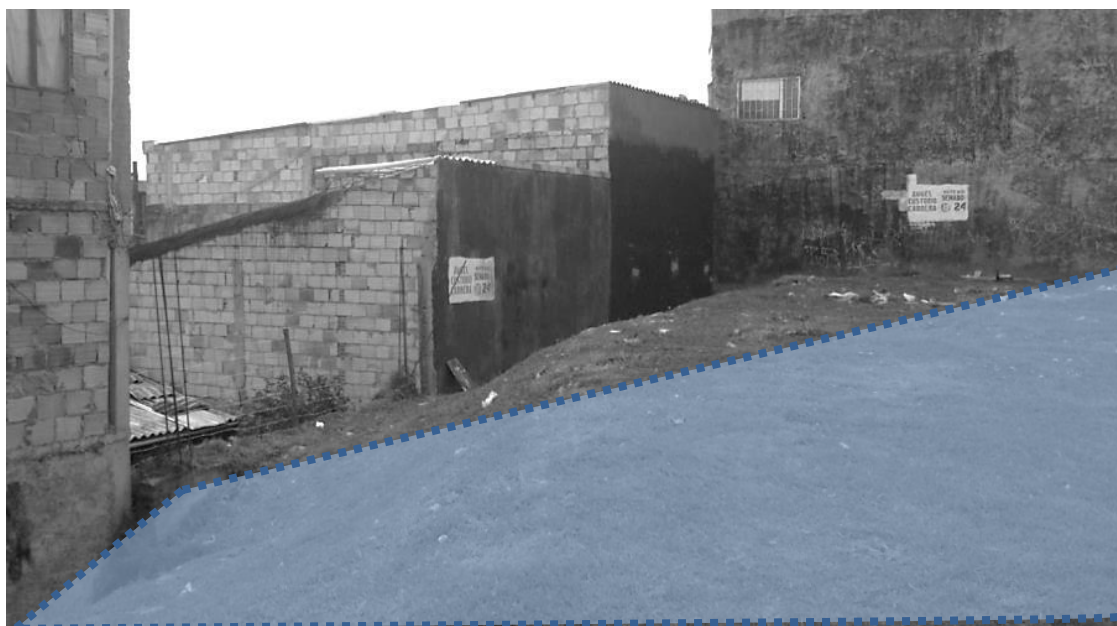
Figura 25. Fotografía del lote este donde se desarrollara el salón comunal Villa Hermosa vista desde Calle 97D. Se evidencia la existencia de un muro de contención, la posterior evaluación y verificación del estado del muro será necesaria para proceder con el diseño Elaboración Propia.
