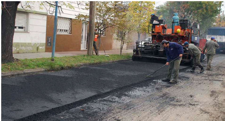
Figura 49: Extendida de Capa de rodadura.
