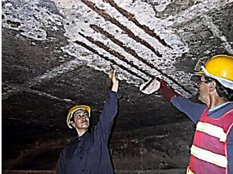
Figura 52: Escarificación placa.
