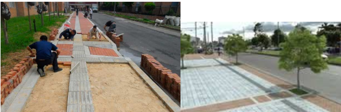
Figura 47: Instalación Adoquines.
