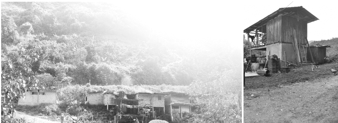
Figura 33: A la izquierda fotografía de consolidación de la vivienda después del conflicto armado, se claramente como sobre sale de la topografía de la montaña apoyándose en pilotes de madera; a la derecha uno de los beneficiaderos o molinos de café. Fuente. Fotografía propia.
