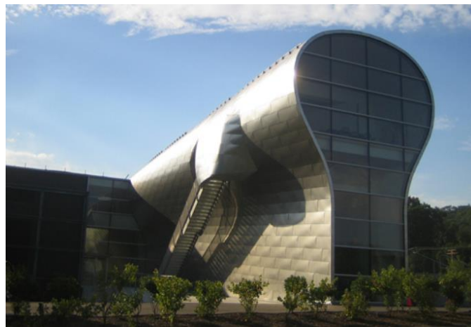
Figura 8 Planta de tratamiento de agua de Whitney tomada de Archidaily
