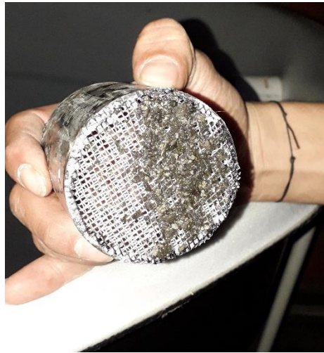
Figura 31: Mantenimiento de primer filtro.
