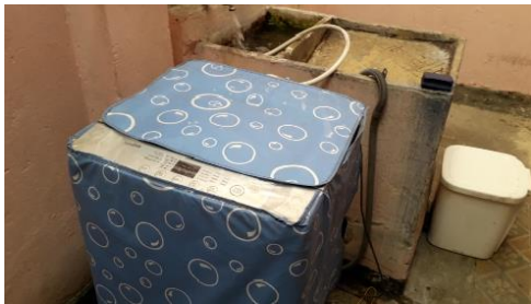
Figura 41: Alimentación de agua lluvia para lavadora.
