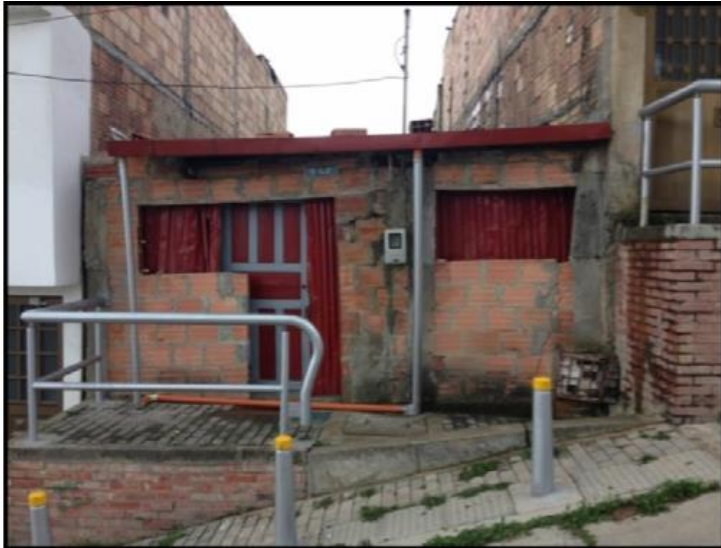
Figura 12: Drenaje artesanal de aguas lluvias.
