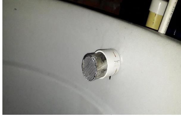
Figura 28: Filtro en el interior del tanque.
