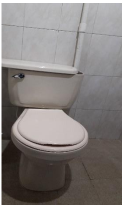
Figura 42: Alimentación de agua lluvia para sanitario.
