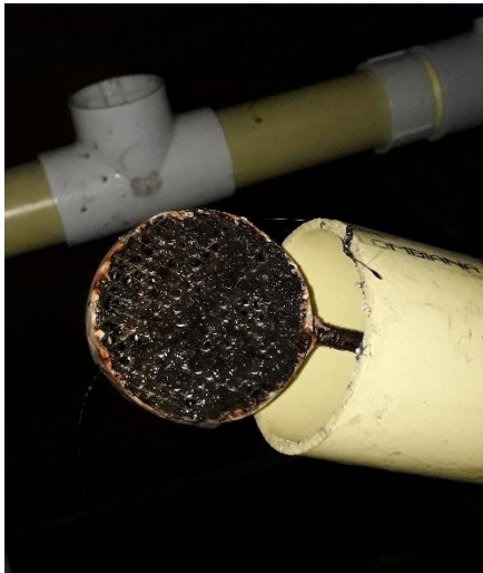
Figura 30: Mantenimiento de primer filtro.
