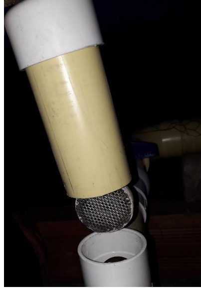
Figura 26: Filtro de agua lluvia 2mm.
