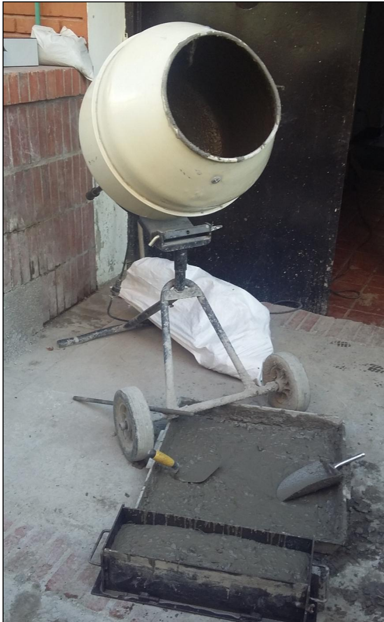
Imagen 47. Elaboración de las mezclas para las Viguetas
